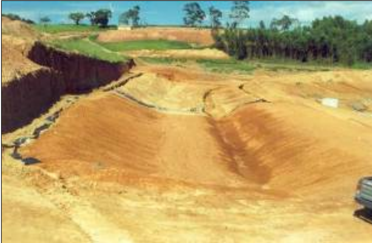
Foto 5 – Vista da área impermeabilizada e revestida com argila.
