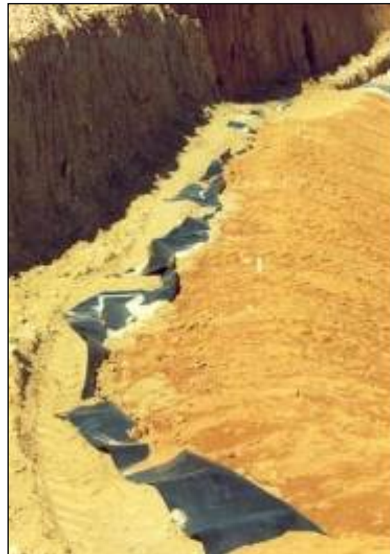
Foto 7 – Valas de ancoragem da geomenbrana – após a fixação
