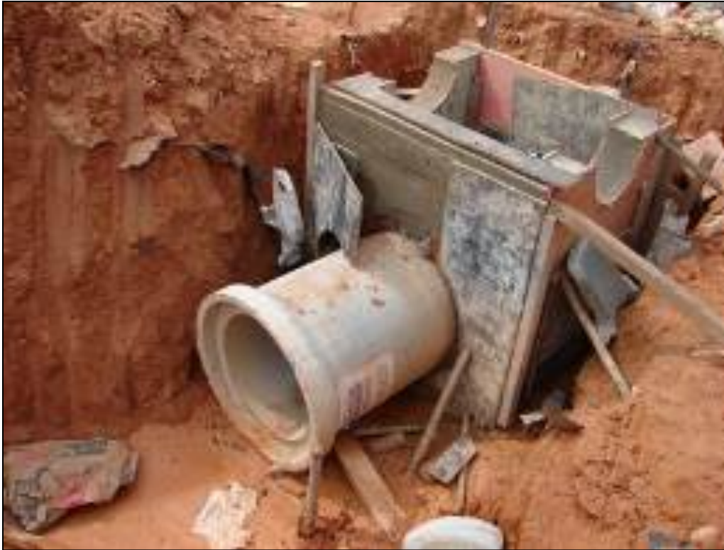
Figura 15 – Detalhes da execução de caixa de passagem.
