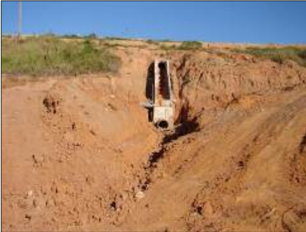
Figura 14 – Vista frontal da escada hidráulica e da caixa de passagem.
