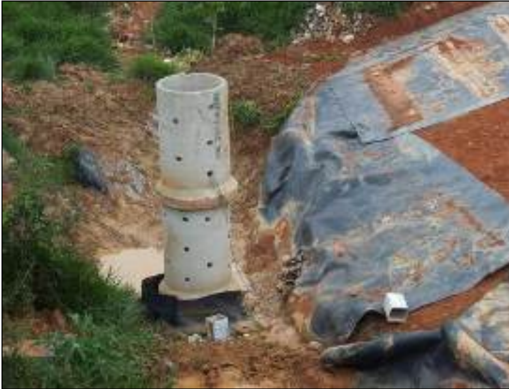
Foto 11 – Detalhes da implantação de chaminé. Atentar para a sua base, também impermeabilizada com manta.
