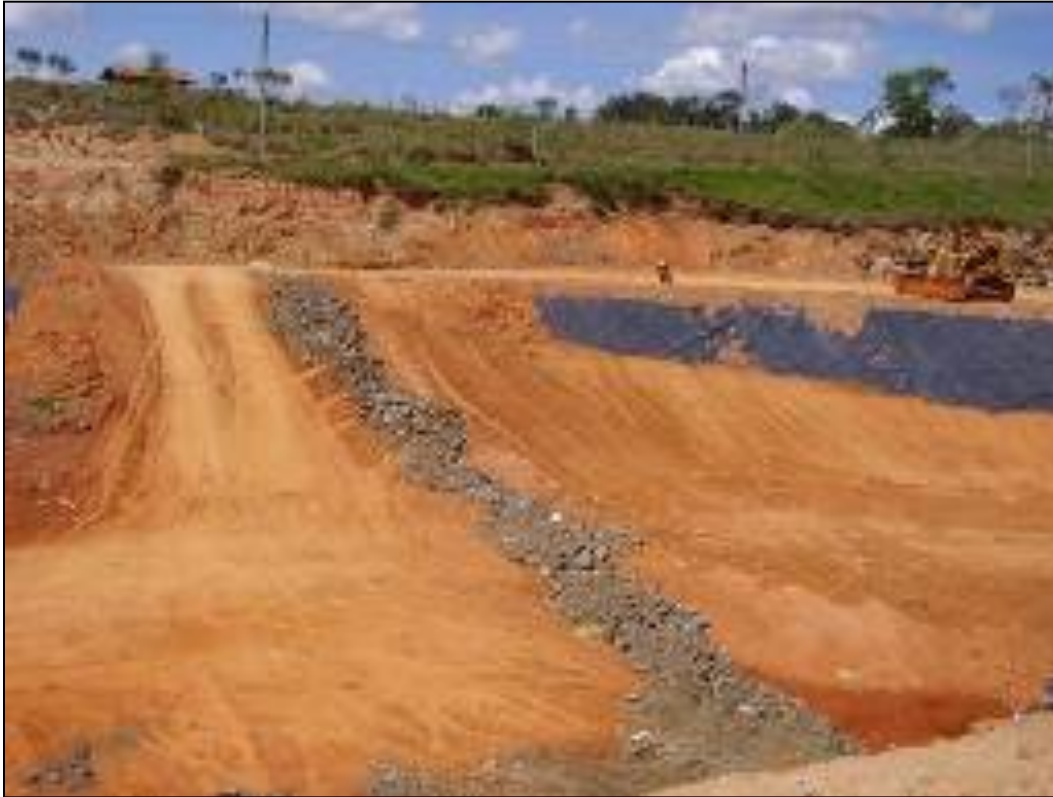
Foto 8 – Detalhes da implantação dos drenos e sua interligação
