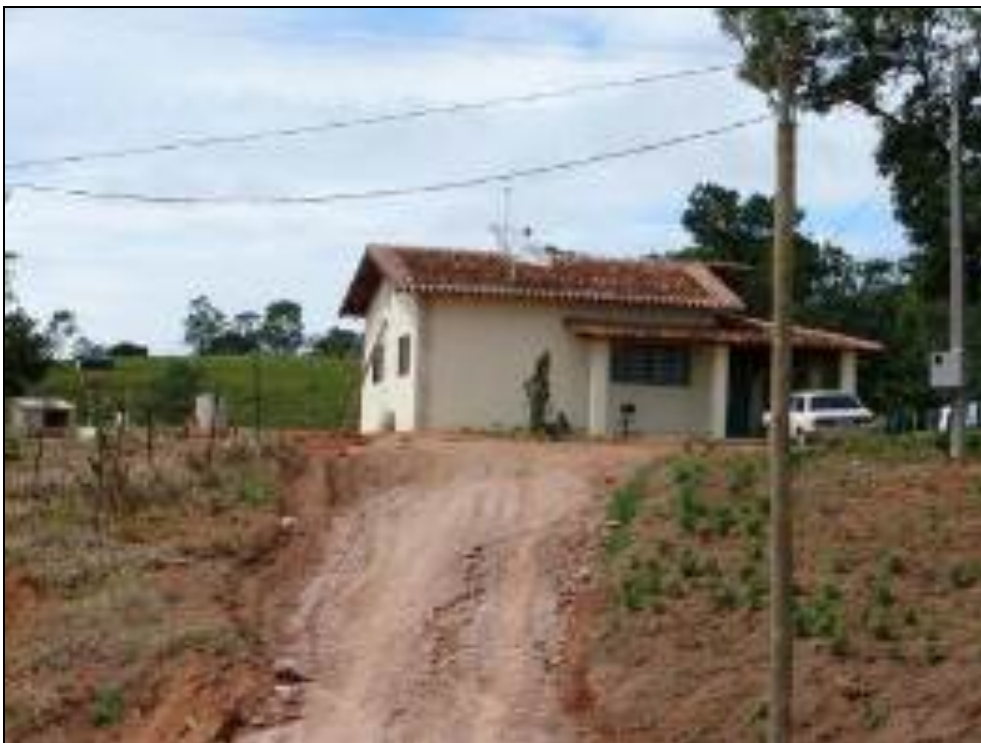
Figura 19 – Vista geral da residência do caseiro e operador de máquinas do aterro – obra executada pela prefeitura.
