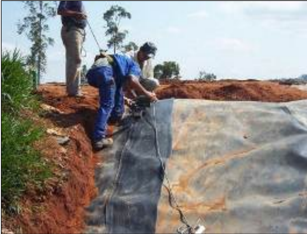
Figura 20 – Detalhe da colagem da manta de geomembrana, efetuada através do processo de termofusão à 400 °C.
