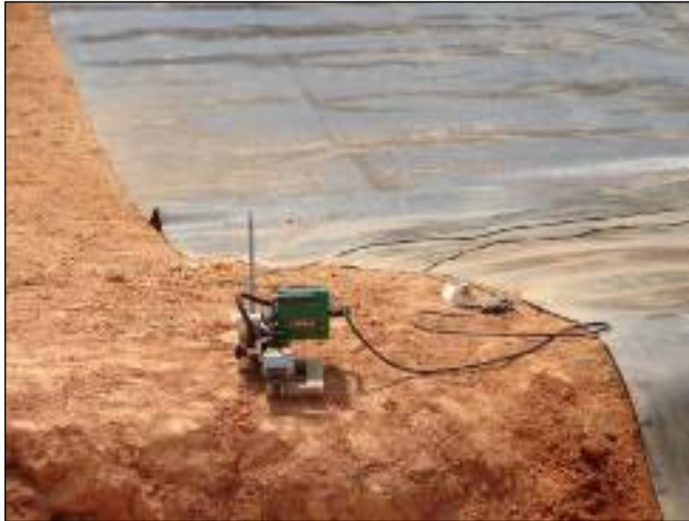
Figura 21 – Detalhe do equipamento de solda por termofusão, importado da Suíça.
