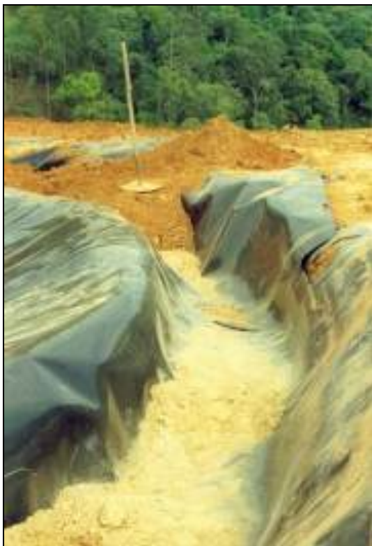
Foto 6 – Valas de ancoragem da manta – antes da fixação
