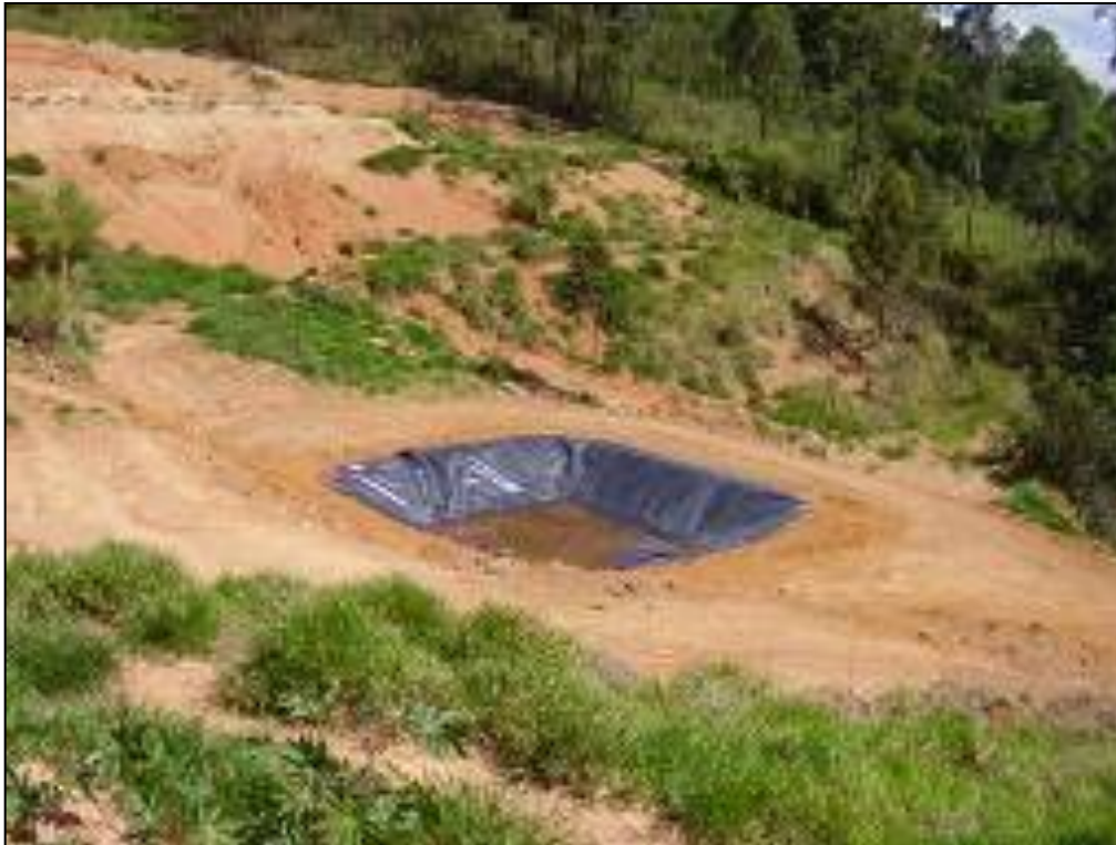
Foto 10 – Vista do segundo tanque de acúmulo de chorume.
