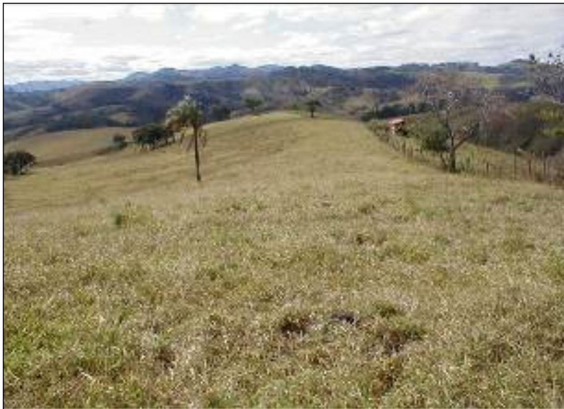
Foto 1 – A partir do ponto mais alto, visão da área do aterro antes do início das obras. Do centro até a divisa direita.
