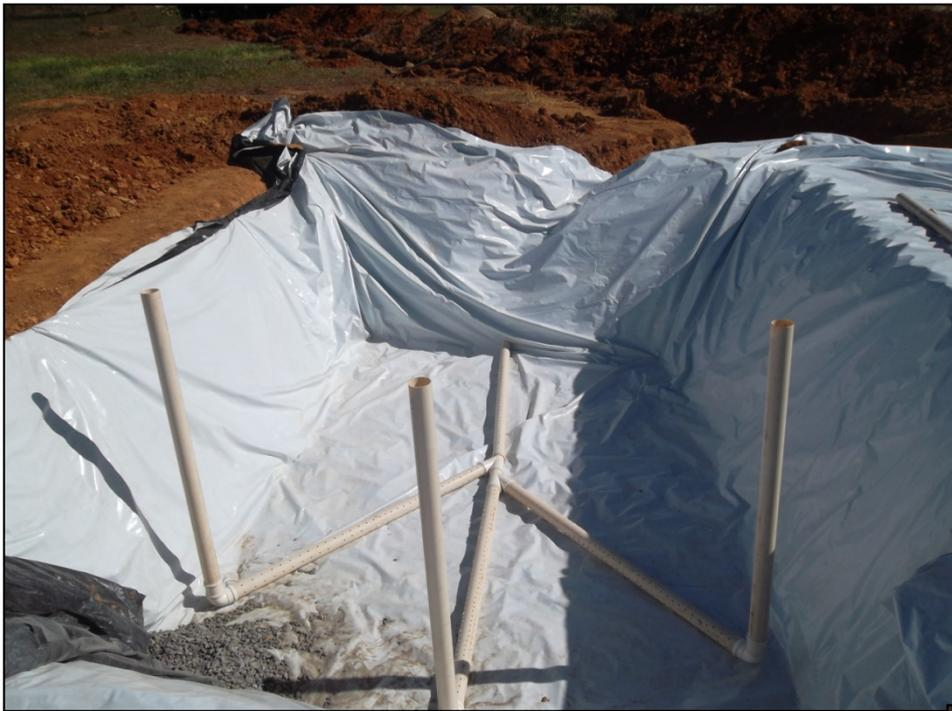
**Figura 7** – Tubulação de drenagem do lixiviado
