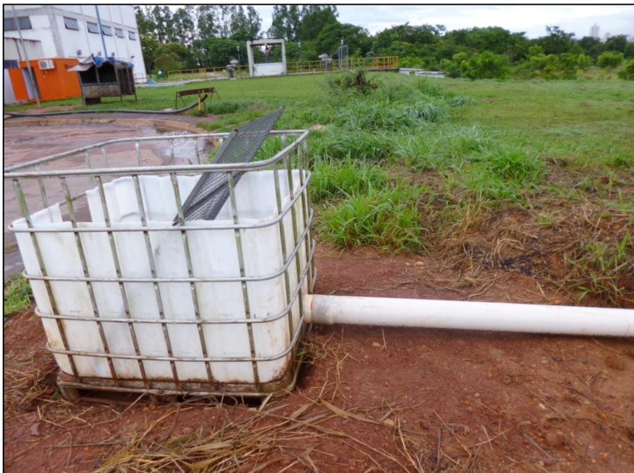
**Figura 15** – Caixa receptora com gradeamento
