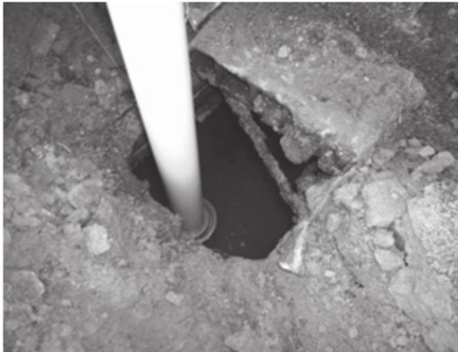
**Figura 1** – Imagem do processo de esgotamento do resíduo de um tanque séptico
