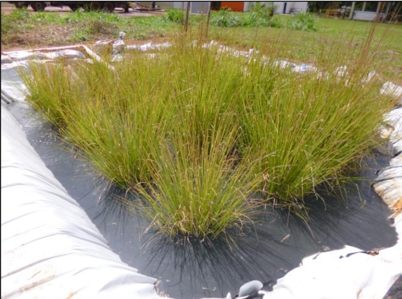
**Figura 3** – Imagem do sistema de alagado construído para tratamento do resíduo em estudo.
