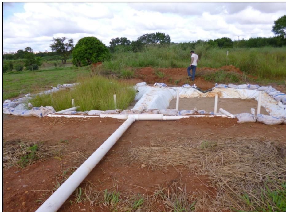
**Figura 16** – Tubulação de drenagem
