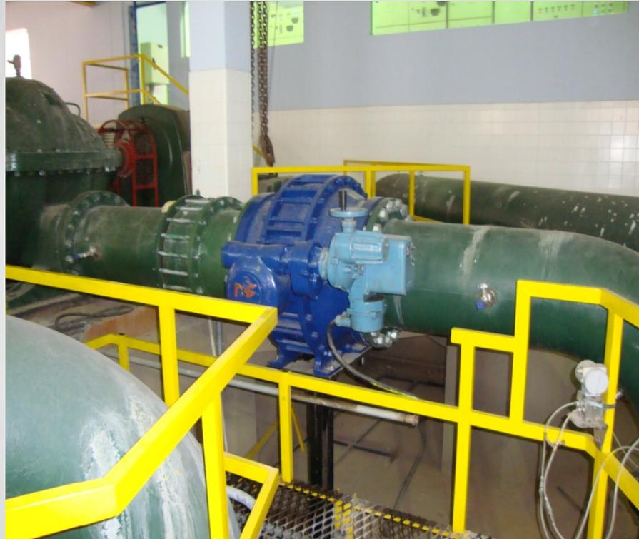
**Indicação dos transdutores de pressão a montante e a jusante da válvula**
