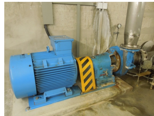
Figura 4 – Utilização de uma BFT em um by-pass em uma rede de abastecimento na Áustria
