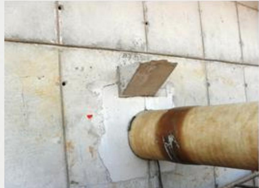
Preparação do substrato, com concretagem para fixação de tubulação
