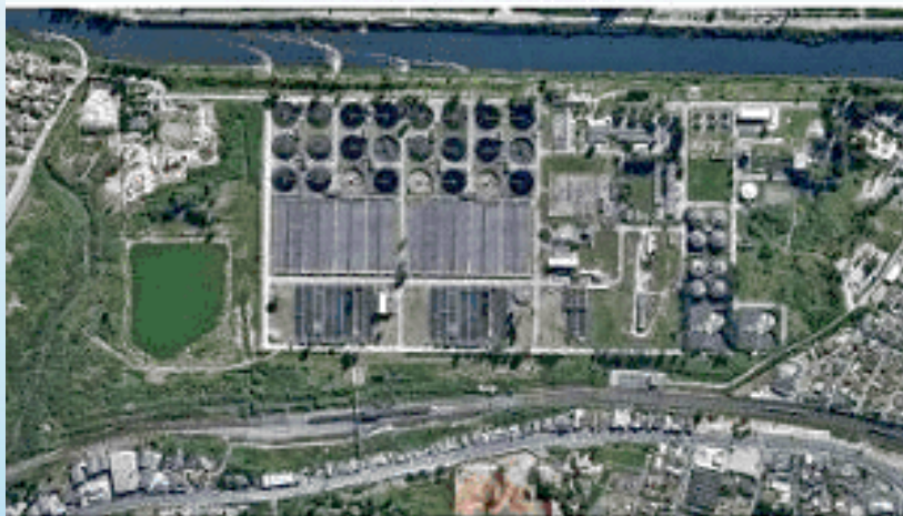
ETE Barueri - Ilustração após ampliação
