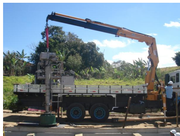
Figura 42 – Posicionamento da máquina para execução do furo em carga DN 700 para derivação no ponto de recalque do booster.
