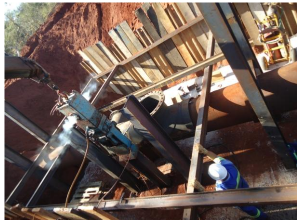
Figura 17 – Cravação de perfis metálicos conforme projeto de ancoragem.
