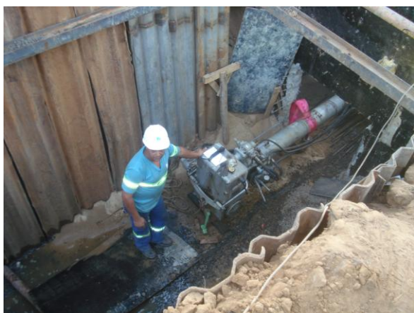
Figura 43 – Execução do furo em carga DN 700 para derivação no ponto de sucção do booster.
