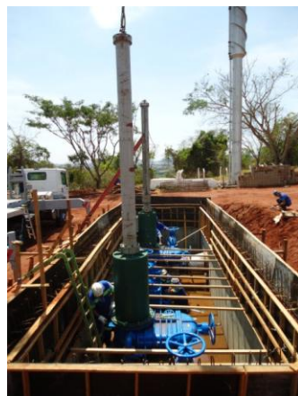
Figura 35 – Trabalho finalizado, desmobilização e desmontagem dos bloqueadores hidráulicos.
