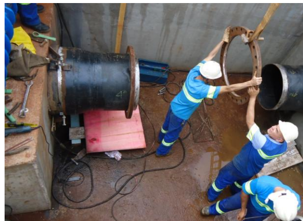
Figura 29 – Preparação e ajustes para montagem do conjunto de válvulas do "by-pass" do booster.
