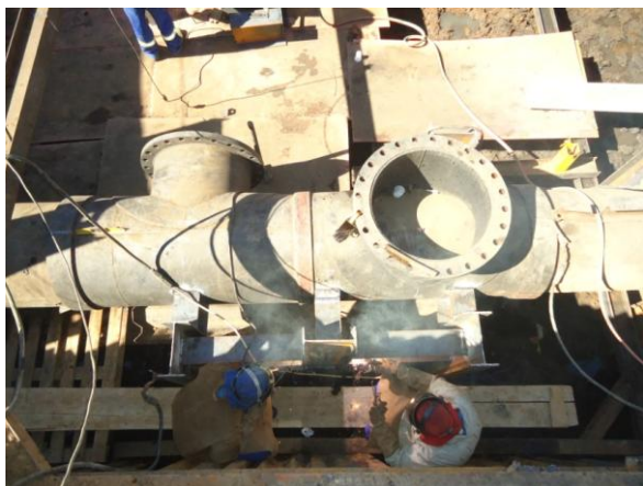
Figura 39 – Soldagem dos travamentos das derivações, conforme projeto.
