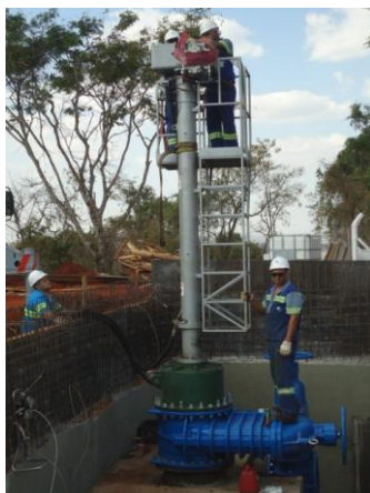
Figura 22 – Execução do furo em carga DN 700 para bloqueio no ponto de sucção do booster.
