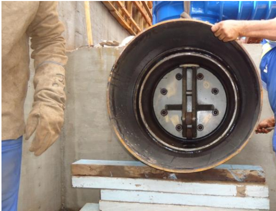
Figura 30 – Cabeçote de bloqueio DN 700mm inserido na tubulação.
