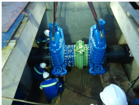
Figura 52 – Finalização da montagem do conjunto de válvulas do “by-pass” do booster.
