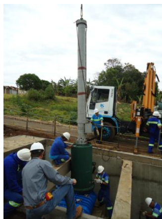
Figura 44 – Posicionamento e instalação dos bloqueadores hidráulicos.
