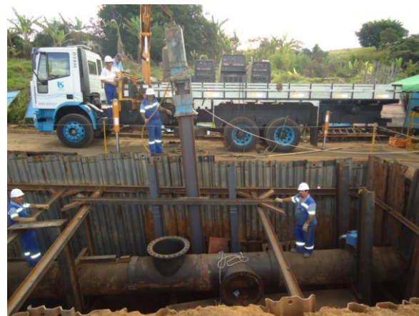
Figura 38 – Cravação de perfis metálicos conforme projeto de ancoragem.
