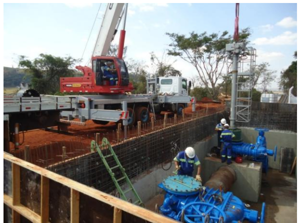
Figura 21 – Execução de teste hidrostático e instalação da máquina de furação em carga para execução do 1º furo de bloqueio.
