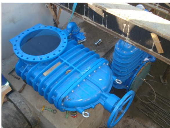
Figura 41 – Execução de teste hidrostático nas válvulas gavetas e juntas das conexões.
