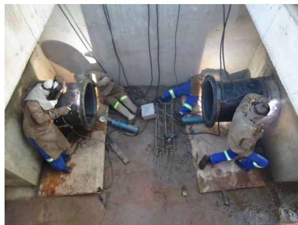
Figura 50 – Soldagem das conexões e flanges.
