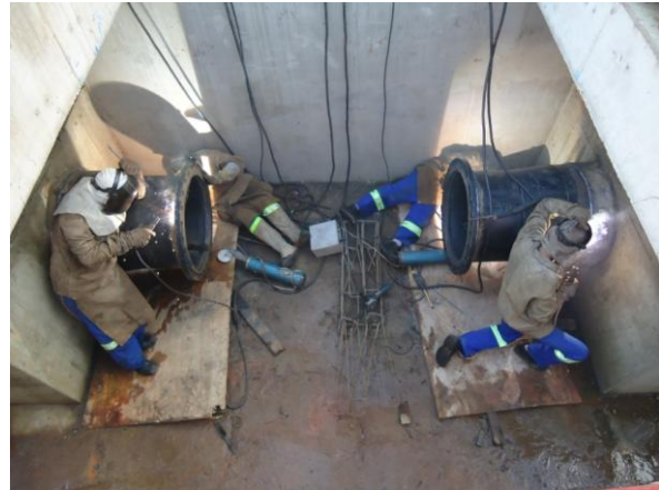
Figura 31 – Soldagem das conexões e flanges.
