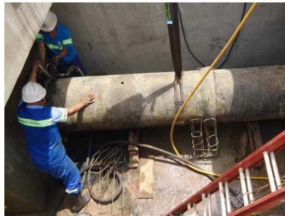
Figura 46 – Corte do segmento da tubulação entre os bloqueadores hidráulicos para instalação de pacote de válvulas do “by-pass” do booster.
