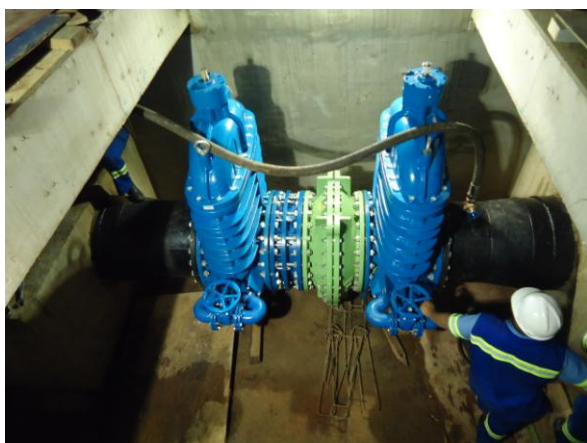
Figura 53 – Equalização da pressão no novo trecho de tubulação com as válvulas do by-pass para retirada dos bloqueadores hidráulicos.
