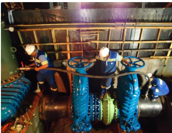
Figura 34 – Equalização da pressão no novo trecho de tubulação com as válvulas do by-pass para retirada dos bloqueadores hidráulicos.
