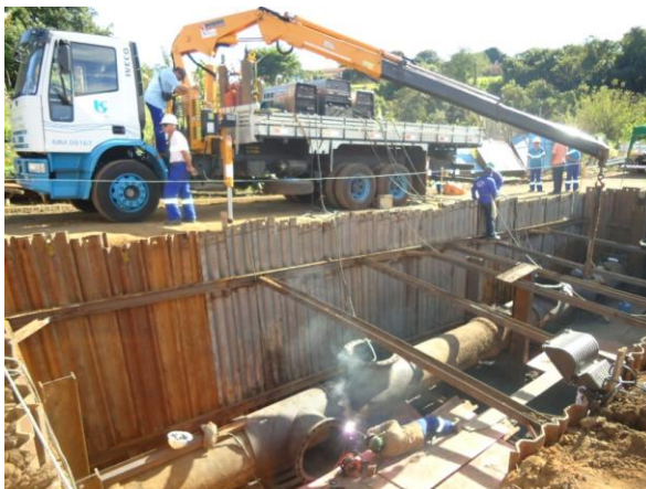
Figura 37 – Posicionamento e montagem dos “Tês” com DN 700 mm.
