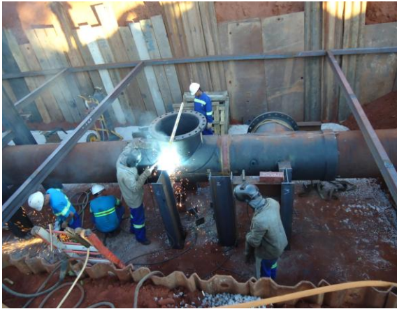
Figura 18 – Soldagem dos travamentos das derivações, conforme projeto.
