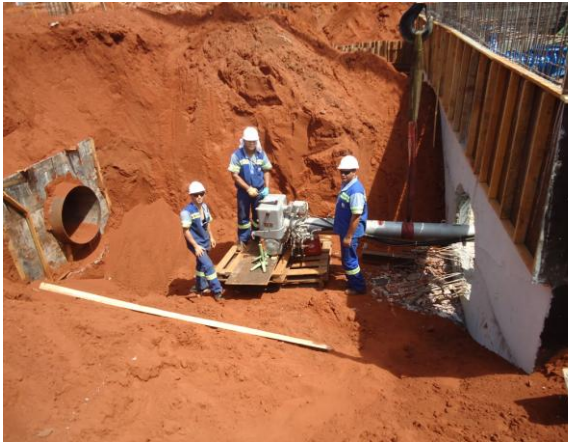
Figura 24 – Execução do furo em carga DN 700 para derivação no ponto de sucção do booster.
