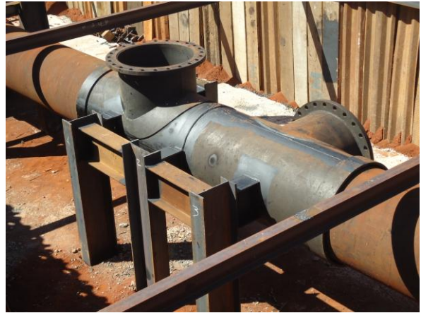
Figura 19 – Finalização da montagem dos “Tês” com DN 700 mm e dos travamentos metálicos.
