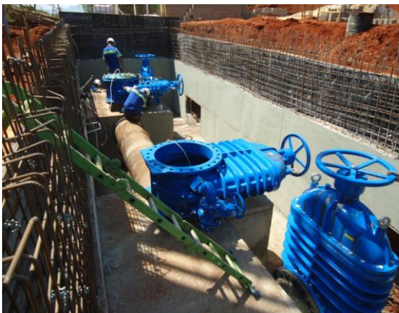
Figura 20 – Execução de teste hidrostático nas válvulas gavetas e juntas das conexões.
