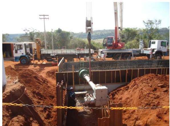
Figura 23 – Posicionamento da máquina para execução do furo em carga DN 700 para derivação no ponto de recalque do booster.
