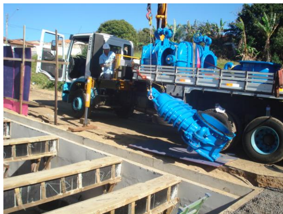
Figura 40 – Posicionamento e montagem das válvulas gavetas com DN 700 mm para furação e bloqueio em carga.
