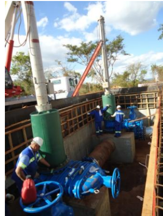
Figura 25 – Posicionamento e instalação dos bloqueadores hidráulicos.
