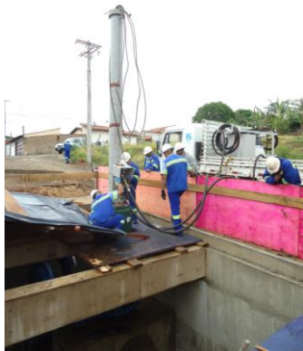
Figura 45 – Intervenção Programada: Início da inserção dos bloqueadores e operação do conjunto moto-bomba do novo booster.
