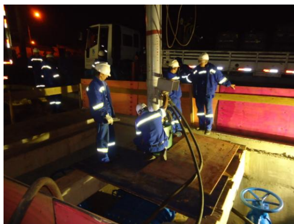
Figura 54 – Trabalho finalizado, retirada dos bloqueadores hidráulicos e desmobilização.
