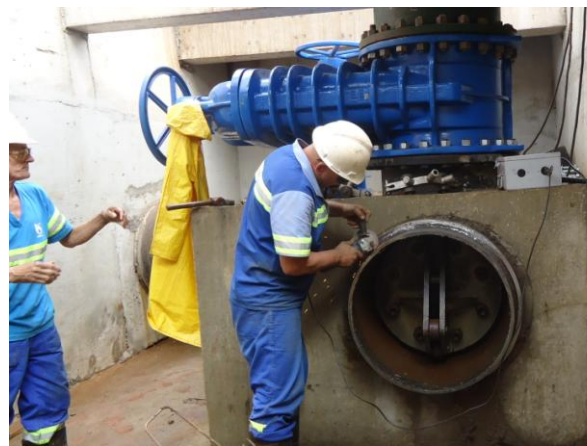
Figura 48 – Cabeçote de bloqueio DN 700mm inserido na tubulação.
