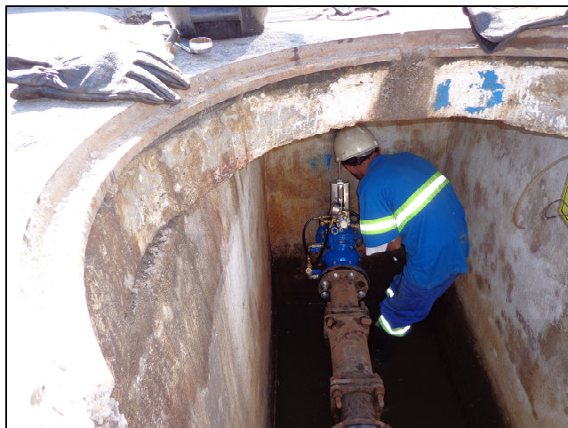
Figura 7: Instalação da VRP gerenciadora
