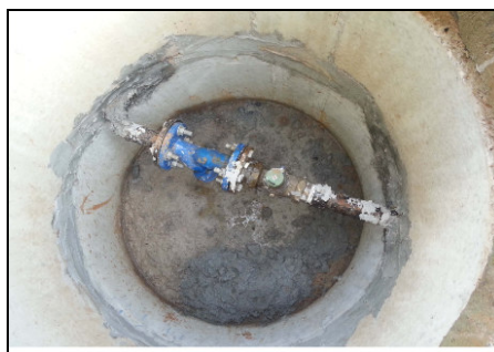
Figura 14: Detalhe da instalação em aduela 900mm
