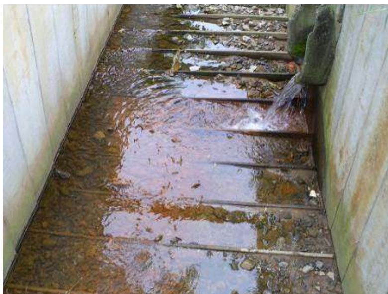
Figura 7: Após a execução, córrego despoluído.
