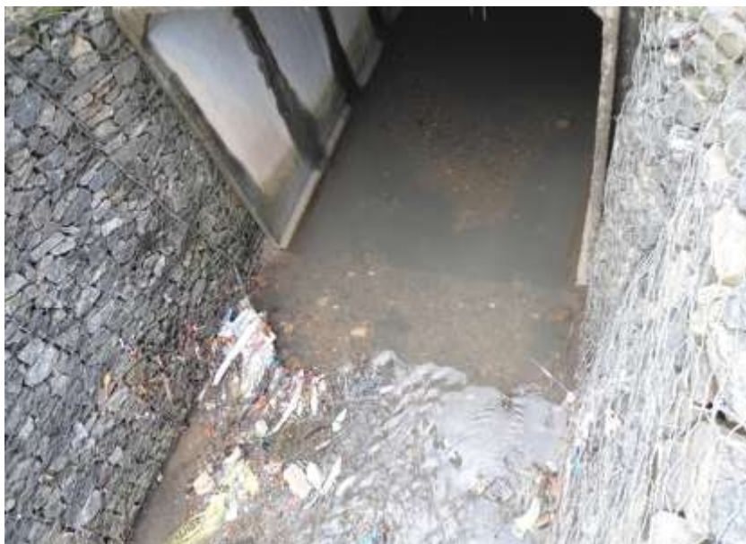
Figura 9: Córrego Cruzeiro do Sul após da zeladoria.
