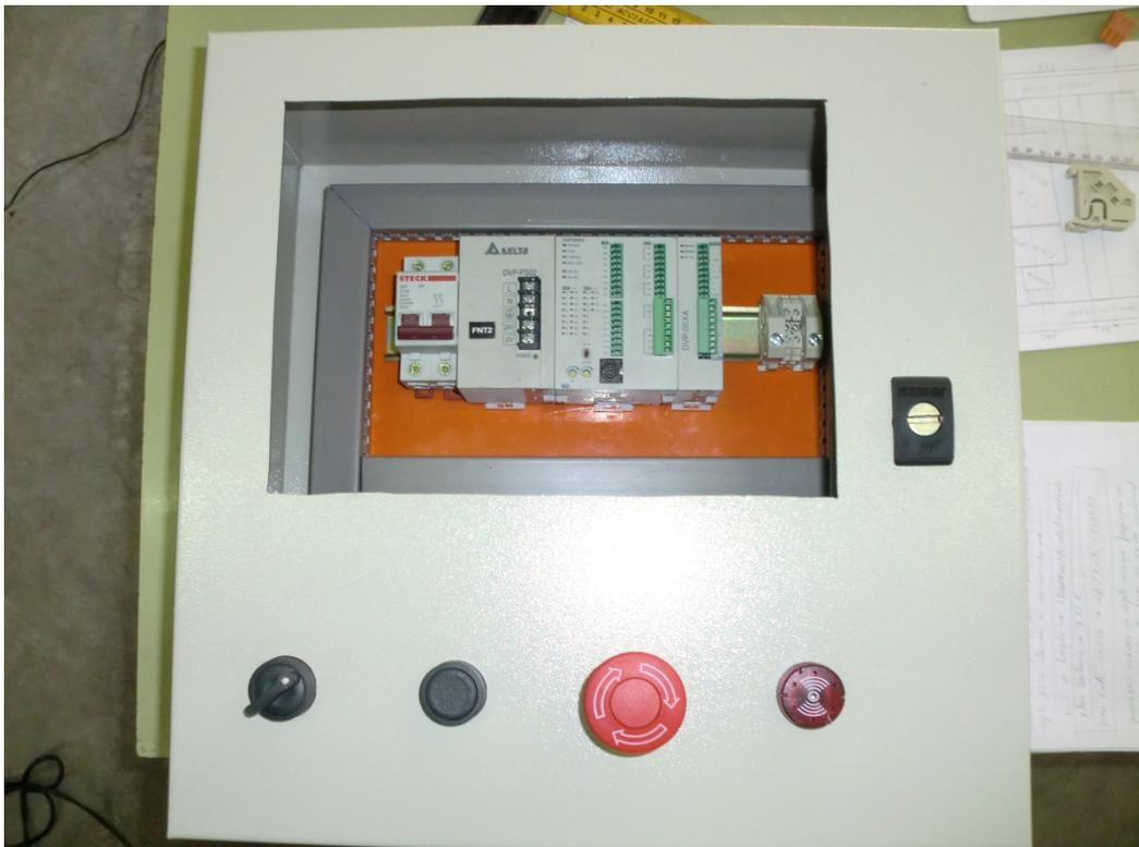
**Imagem 3 – Painel Automatizado para Sistema de Queima de Biogás**
