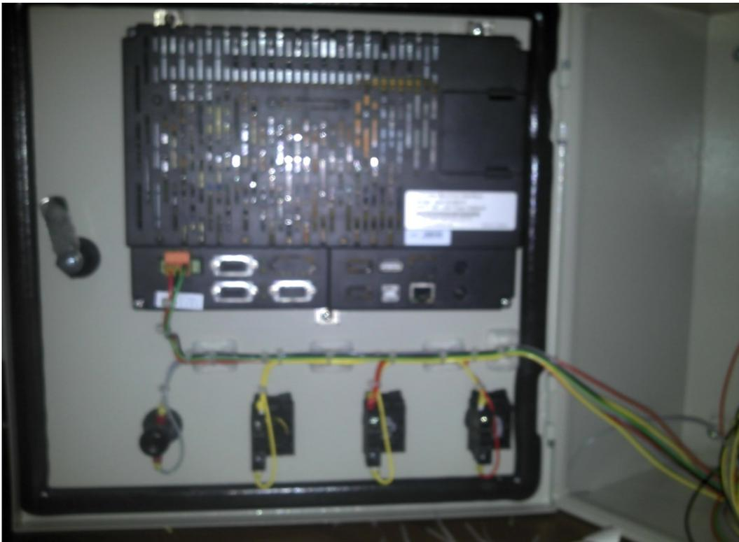
**Imagem 7 - Interligação dos componentes da porta com a placa de montagem**
