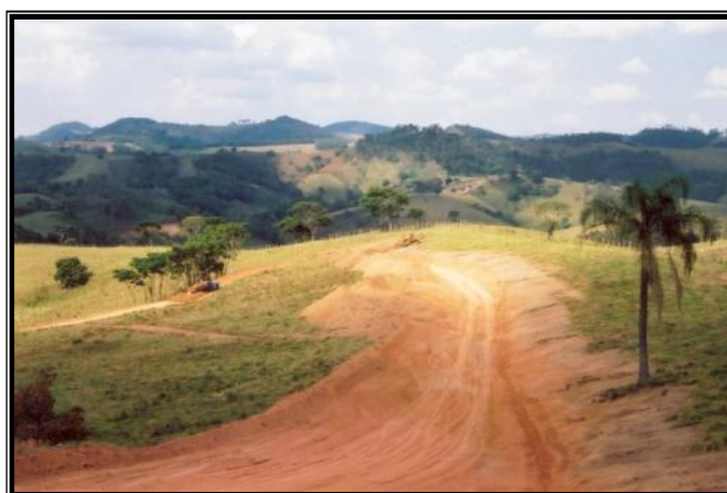
Figura 5 ó Vista da implantação da via inicial de acesso á área de disposição de resíduos, a partir do topo do terreno.
