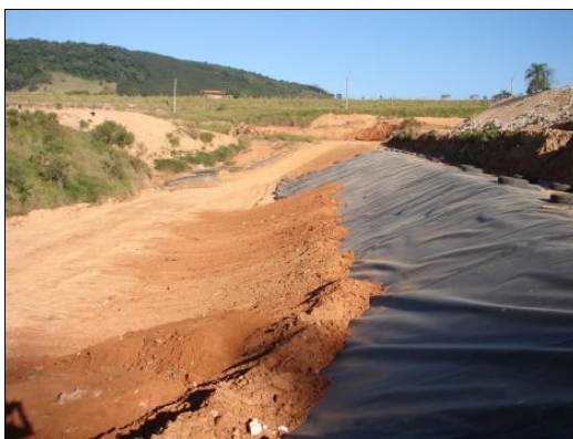
Figura 24 ó Vista de área impermeabilizada, no momento que recebia o recobrimento de 0,50m de terra de proteção mecânica.
