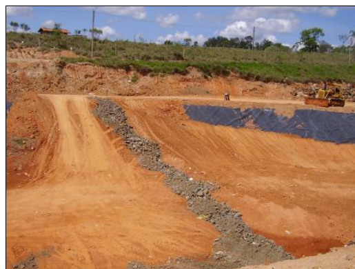
Figura 29 é Detalhes da implantação do colchão drenante em rachão.
