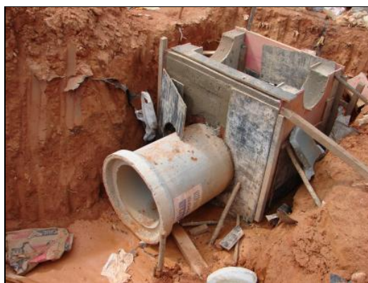
Figura 21 é Detalhes da execução de caixa de passagem.
