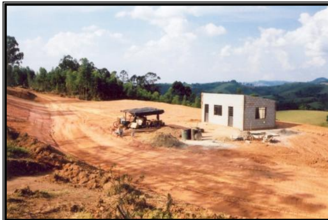
Figura 3 - Implantação do platô de entrada e do escritório administrativo. Foram executados serviços de corte e de aterro para a implantação do platô.
