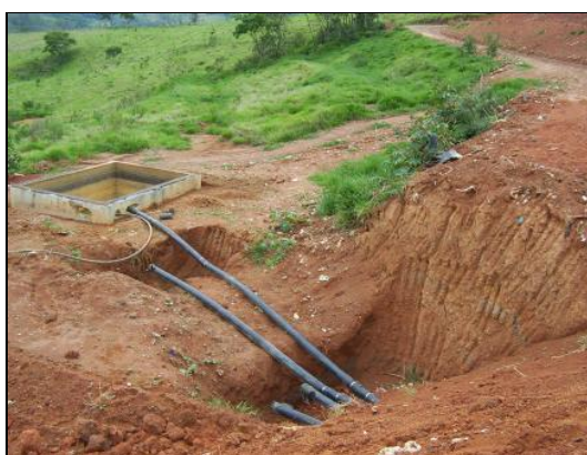
Figura 15 - Interligação definitiva dos tubos responsáveis pelo transporte lixiviado (chorume) para o tanque de acúmulo.
