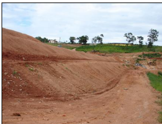
Figura 20 é Vista geral do aterro com a primeira e segunda células preenchidas e com recobrimento final em terra, restando apenas a necessidade de plantio de grama final e a implantação das canaletas longitudinais de águas pluviais.
