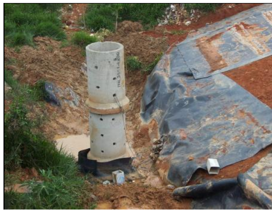
Figura 17 ó Detalhes da implantação de chaminé. Atentar para a sua base, também impermeabilizada com manta.
