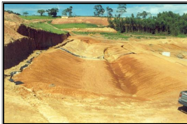
Figura 12 ó Vista geral da área impermeabilizada que possibilitou o início da operação de disposição final dos resíduos sólidos.
