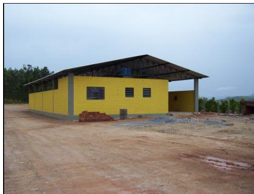
Figura 18 ó Vista geral do galpão, após a sua implantação em 2005.
