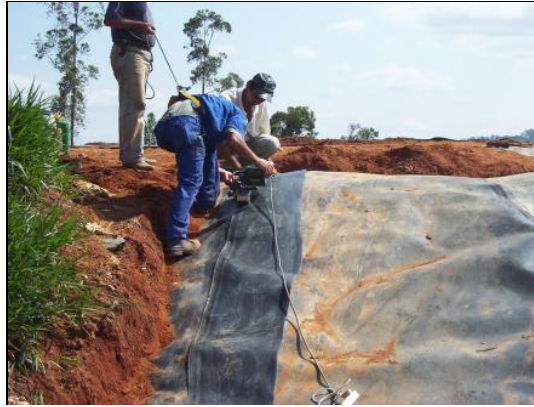
Figura 16 ó Detalhe da colagem da manta de geomembrana, efetuada através do processo de termofusão à 400 °C.
