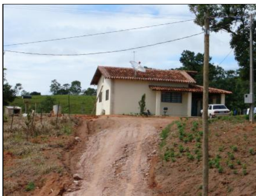
Figura 14 ó Vista geral da residência do caseiro e operador de máquinas do aterro ó obra executada pela prefeitura.
