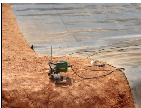
Figura 23 ó Detalhe do equipamento de solda por termofusão, importado da Suíça (SUSTEN CENTRISTA; 2009)
