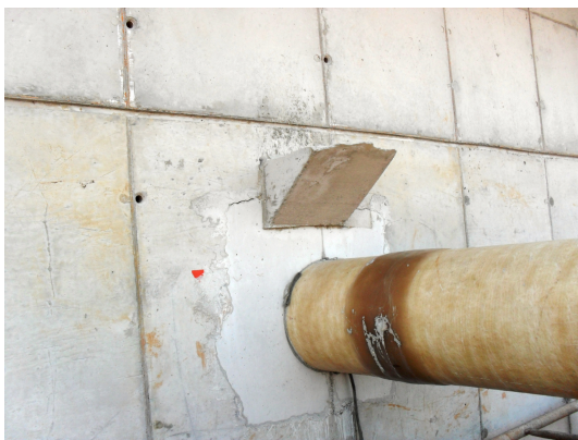
Figura 4 - Preparação do substrato, com concretagem para fixação de tubulação
