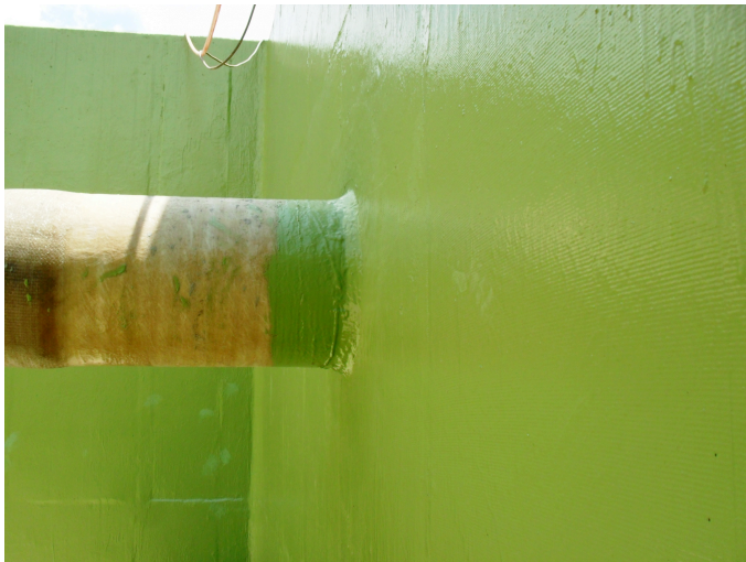
Figura 6 - Vista parcial de parede impermeabilizada
