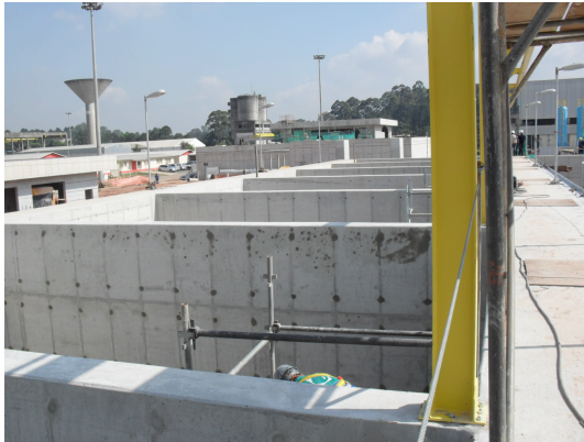
Figura 3 - Preparação do substrato, com fechamento dos furos dos espaçadores
