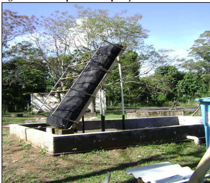
Figura 1: Sistema piloto de evaporação natural de lixiviado (com painel evaporativo).
