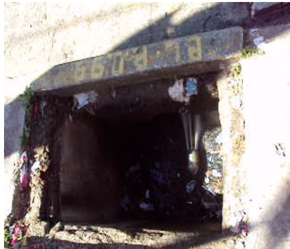
Figura 6 - Galeria ligada em esgoto
