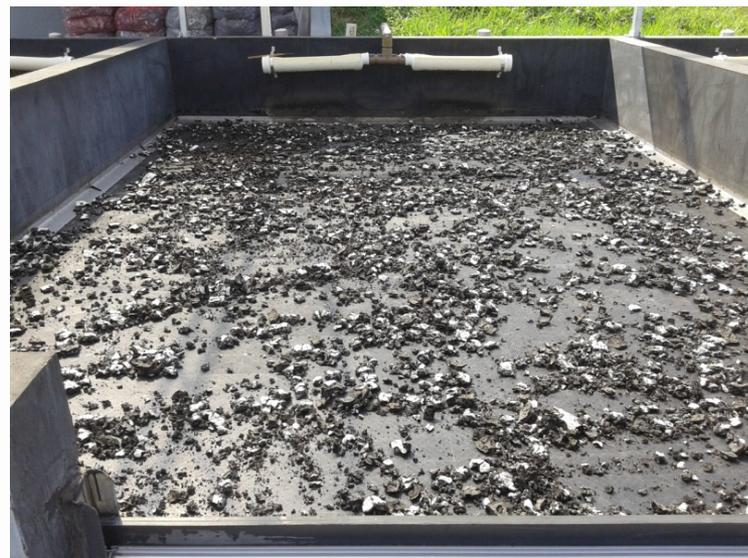
Figura 2: Leito de secagem com piso de blocos drenantes
