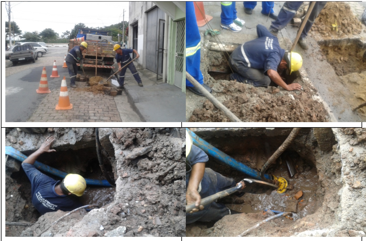
Figura 11: Fotografias do trabalho de reparo do vazamento na Rua Pais Barreto.
