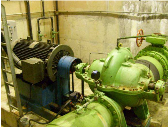
Figura 2: Conjunto moto – bomba P-3C com acoplamento tradicional e acionamento por soft start.
