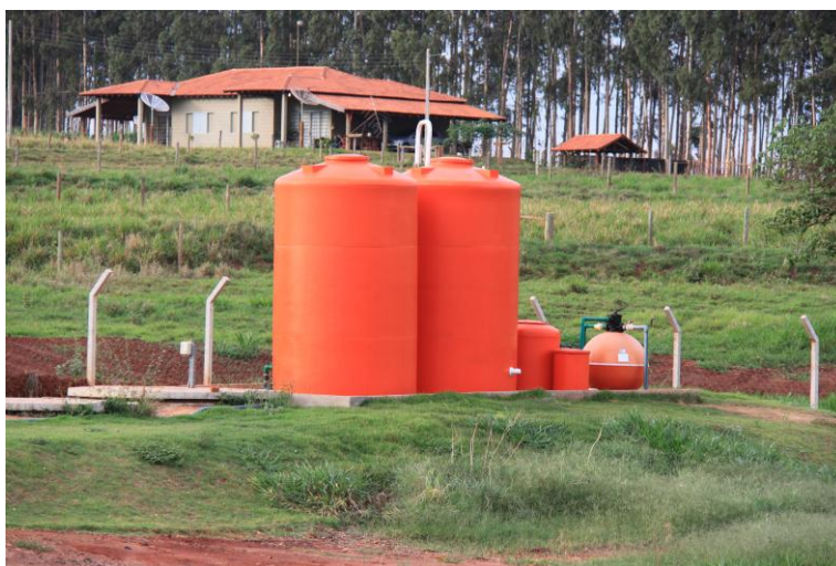
Figura 15. Estação de tratamento de esgoto (ETE) para efluente doméstico do campus da IES em estudo
