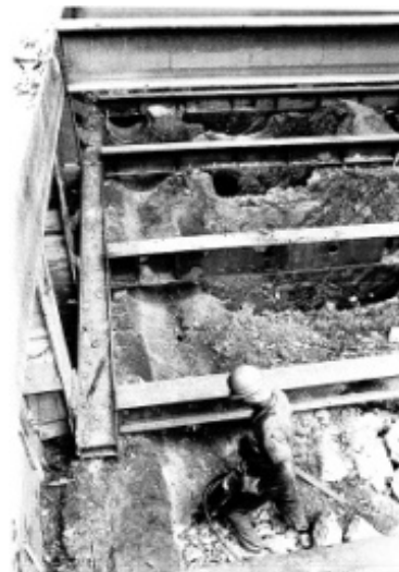
Foto 1 – Detalhe do CT 800mm semi-demolido.
