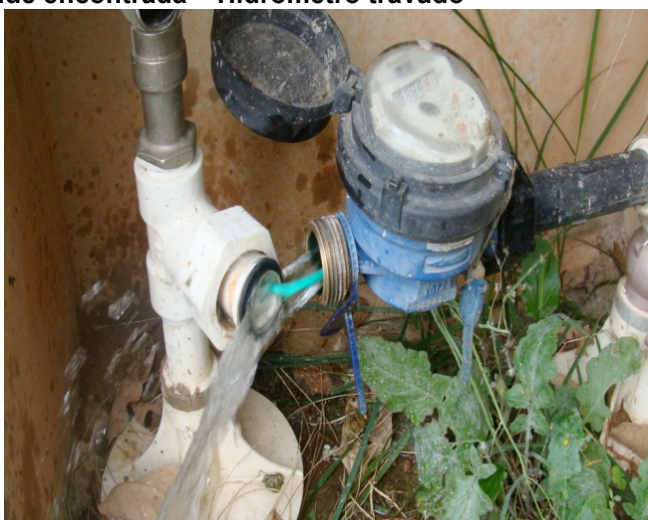
Figura 14: Fraude encontrada – Hidrômetro travado
