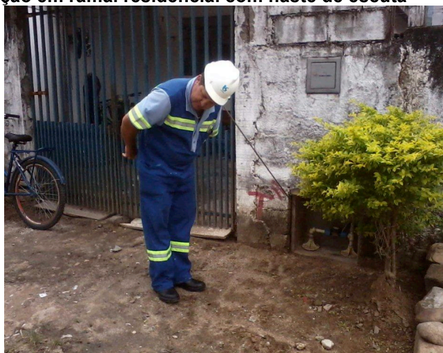
Figura 9: Inspeção em ramal residencial com haste de escuta
