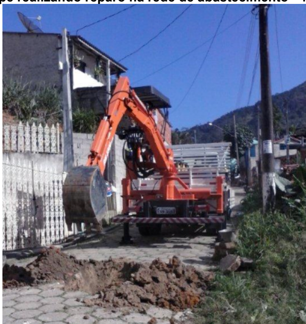
Figura 11: Equipe realizando reparo na rede de abastecimento - 1
