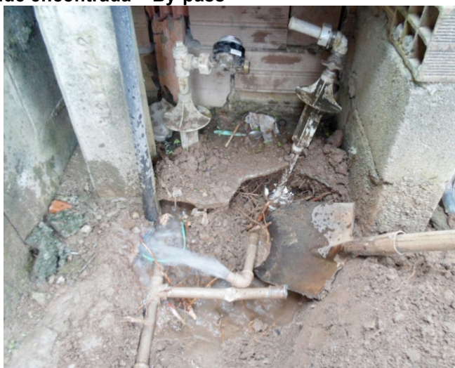
Figura 14: Fraude encontrada – Hidrômetro travado
