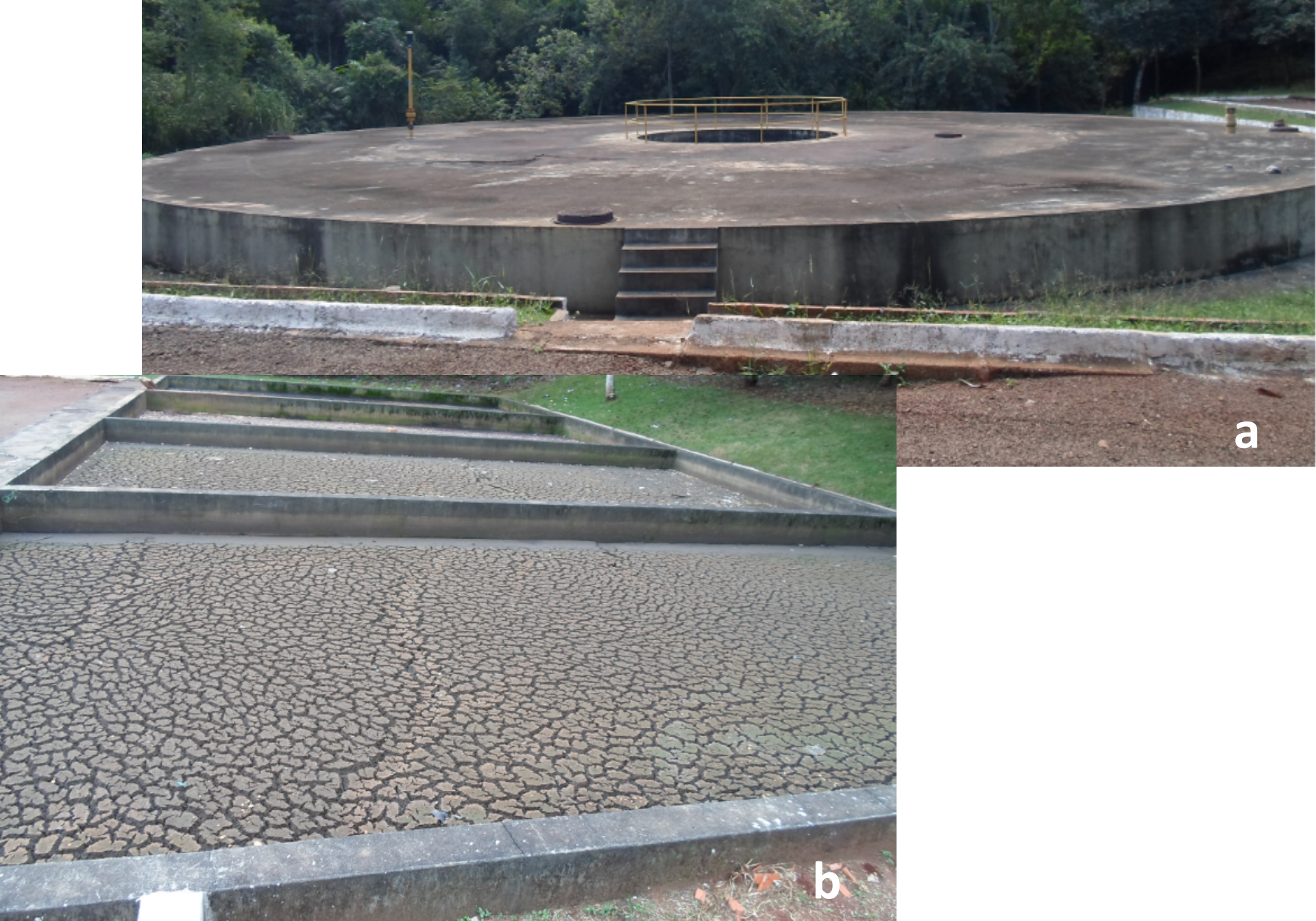
Figura 2 – (a) RALF; (b) Leito de secagem.
