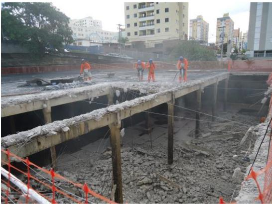
FIGURA 14 – Demolição da laje de cobertura
