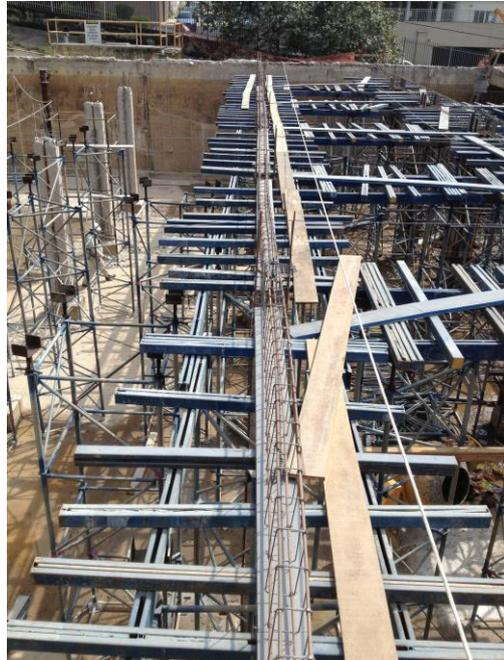
FIGURA 29 – Preparação de armação e formas
