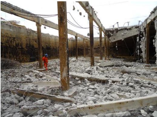
FIGURA 18 – Demolição da laje de cobertura
