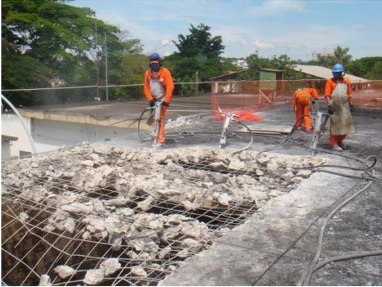
FIGURA 12 – Demolição da laje de cobertura
