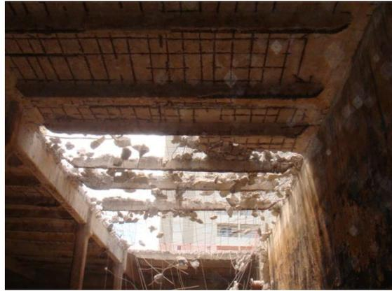
FIGURA 13 – Demolição da laje de cobertura
