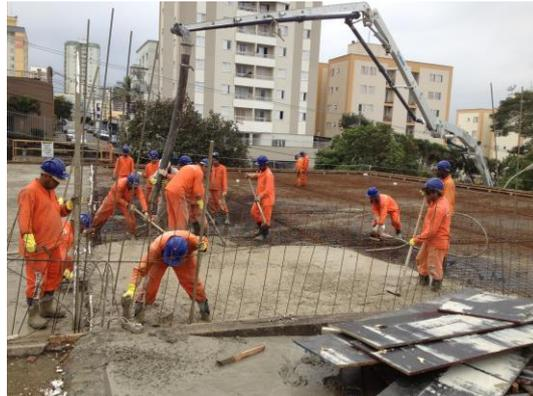
FIGURA 31 – Concretagem da laje
