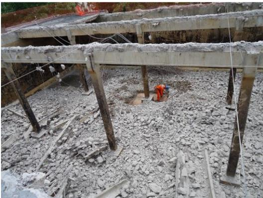
FIGURA 16 – Demolição da laje de cobertura
