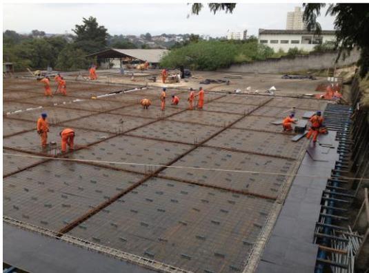
FIGURA 30 – Preparação de armação e formas
