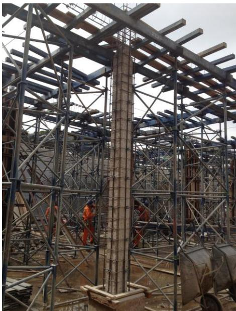
FIGURA 37 – Preparação de armação e formas
