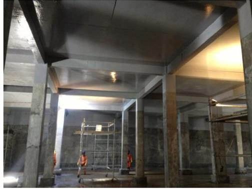
FIGURA 34 – Proteção superfície interna seca
