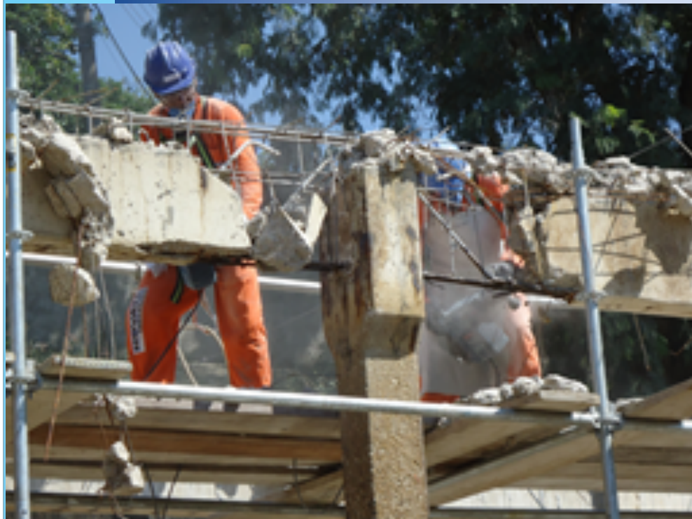
Demolição das Vigas
