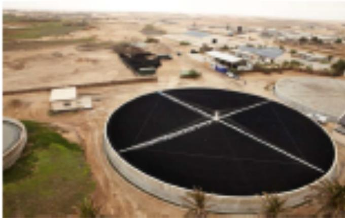
O consumo de energia para bombear a água até aos distribuidores é de 624 kWh/d implicando 0,16 kWh/kgDQO ou 0,11 kWh/m<sup>3</sup> de água tratada (incluindo nitrificação e excluindo os tratamentos preliminar e posterior). Comparado com Lodos Ativados, os filtros percoladores possuem vantagens significativas no que respeita aos custos de operação.
