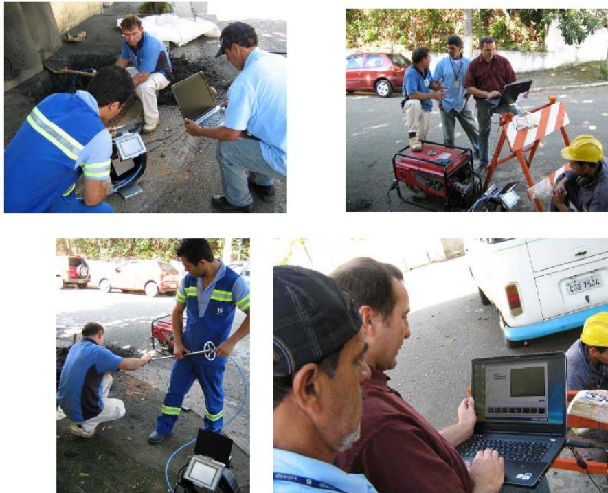
Figura 11: Inspeção televisa da rede o término da limpeza da tubulação.
