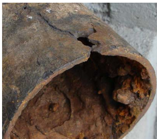
Figura 2: Parede com fissuras.
