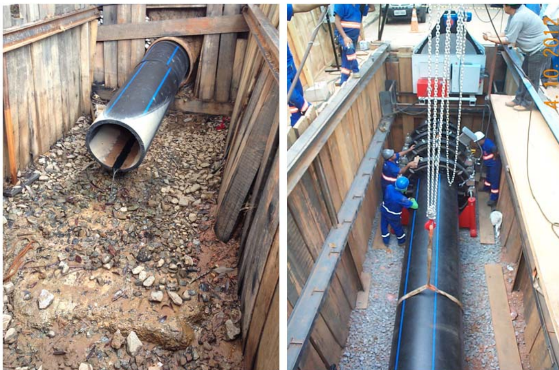
Figura 5: inserção de tubos ou slipilining , na Adutora Jd. América-Lapa.
