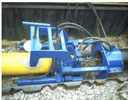
Figura 8: Inserção por Swagelining.
