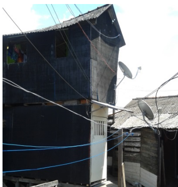
Foto 6-Água vazando embaixo da palafita
