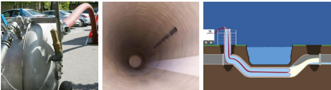
Sistema Cured in Place Pipe (CIPP) – Tubulação Curada Insitu
