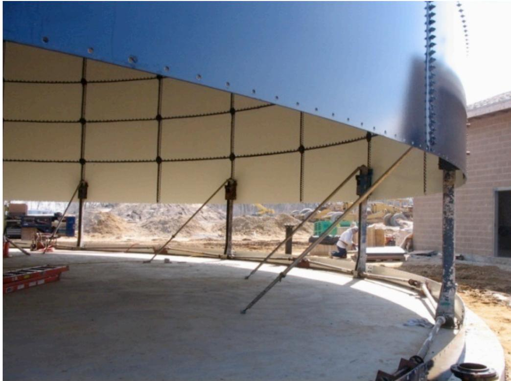
→ Execução das paredes – sistema em aço parafusado.
