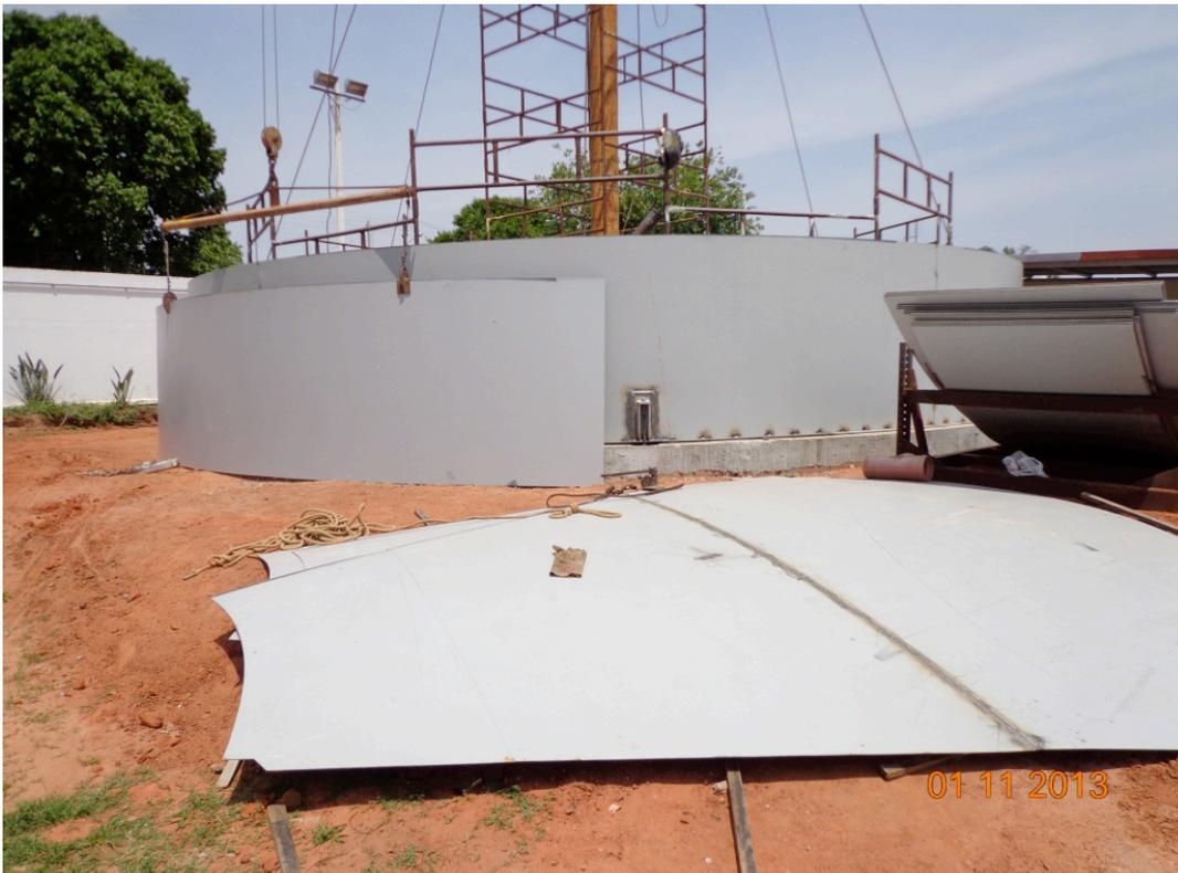
→ Execução das paredes – sistema em aço soldado.
