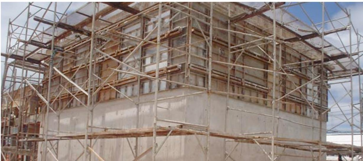
→ Execução das paredes – sistema em concreto armado.
