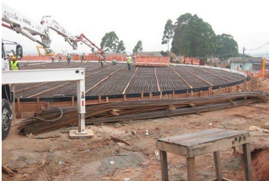
→ Vista mostrando a execução da base, que pode ser utilizada em qualquer dos tipos de reservatório.
