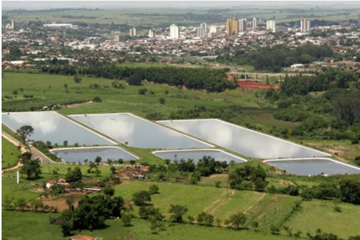
Figura 03. Foto ilustrando as Lagoas Anaeróbias seguidas de Facultativas da ETE - Lins
