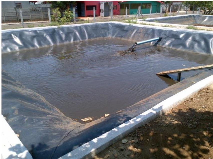
Figura 10 - Disposição do lodo no leito de drenagem
