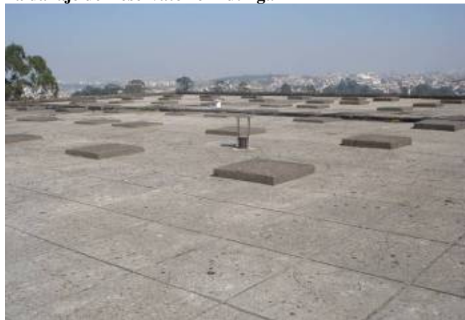
Figura 6 - Vista externa da laje do Reservatório Mutinga
