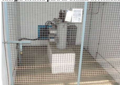
Figura 13 - Transformador de energia elétrica para as demais necessidades
