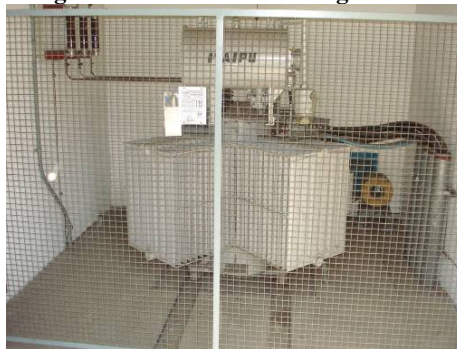
Figura 13 - Transformador de energia elétrica para as demais necessidades
