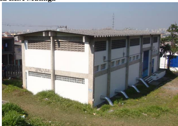
Figura 8 - Vista externa da EEA Mutinga
