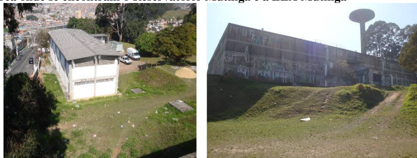
Figura 2 - Área onde se encontram o Reservatório Mutinga e a EEA Mutinga
