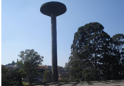
Figura 19 – Reservatório elevado posicionado ao lado direito do Reservatório Mutinga
