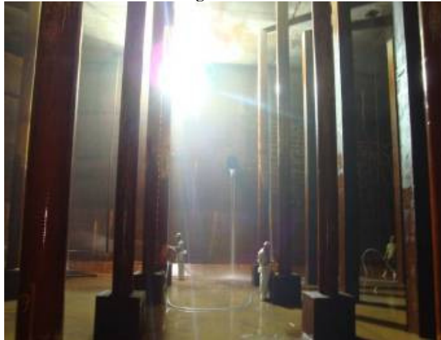
Figura 5 - Pilares dentro do Reservatório Mutinga
