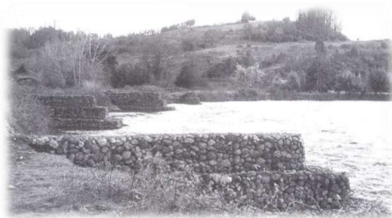
Figura 12 – Proteção Indireta – localização e funcionamento de espigões. Fonte: SILVA. (2004).
