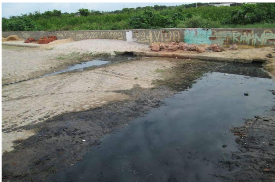
Figura 5 – Esgoto lançado na planície de alagamento do Rio Poti
