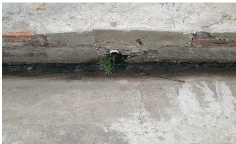
Figura 3 – Esgoto doméstico sendo lançado em coletor de águas pluviais
