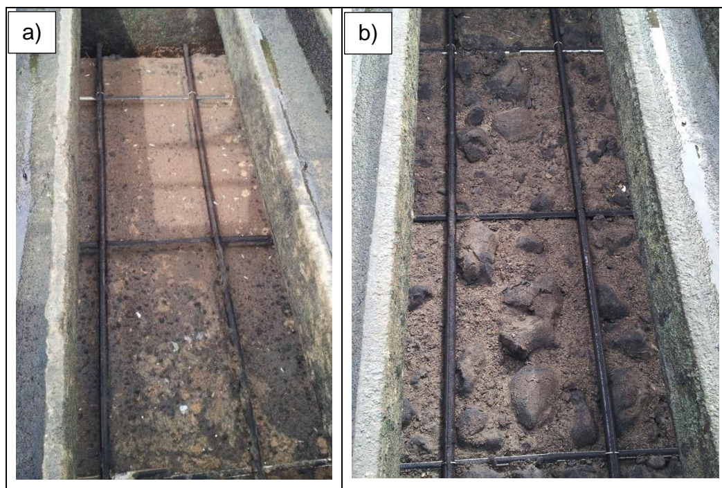
Figura 3: Aparência das câmaras esquerda (a) e direita (b) do Filtro 23 sujas (antes da lavagem).
