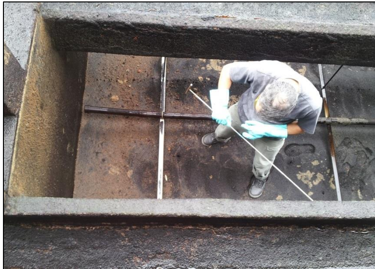
Figura 4: Utilização de barra metálica graduada para levantamento da altimetria do Filtro 23.
