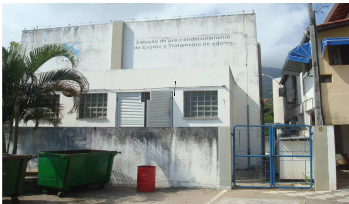
Figura 2 – Vista frontal da EPC Saco da Capela.
