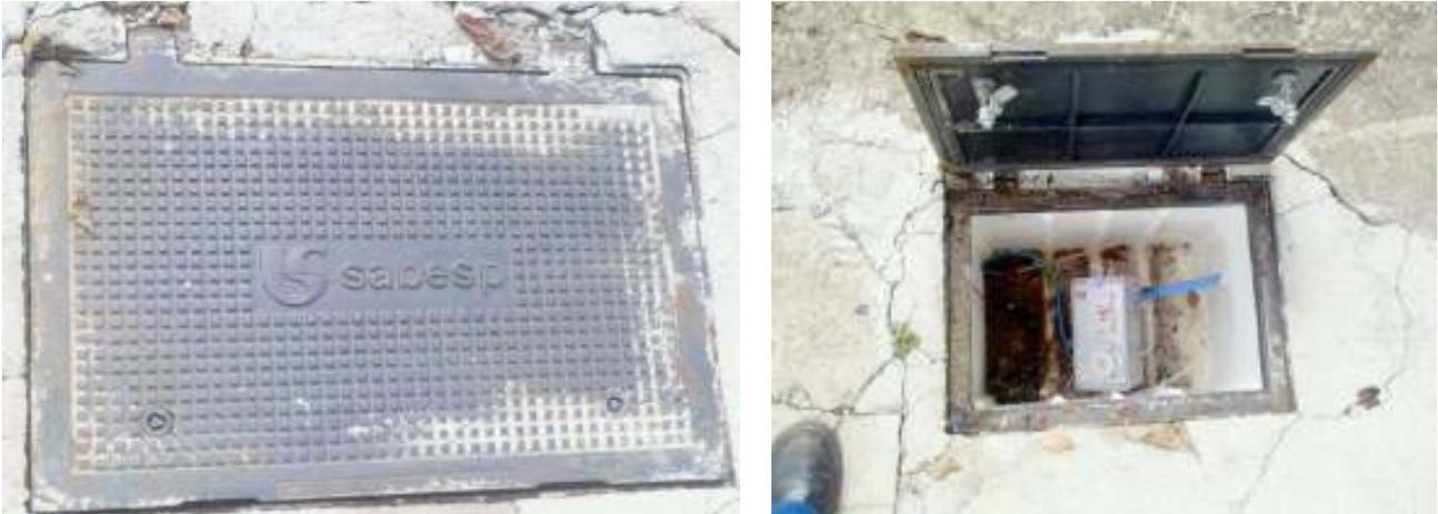
Figura 7 – Exemplo de caixa de polietileno instalada em ponto crítico.
