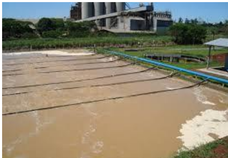
Fig. 1 – Aeração por ar difuso com cadeias oscilantes - Wasserlink
