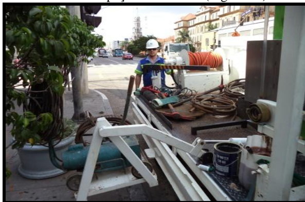
Figura 01 – UDE – Elevador para carga e descarga de equipamentos
