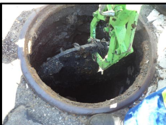
Figura 04 – UDE – Acessório para remover tampões metálicos de dentro de PVs.
