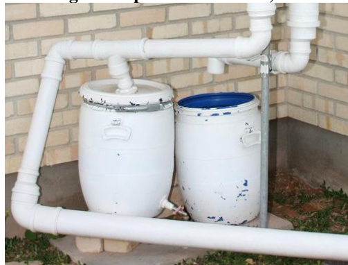
Figura 3 - Dispositivo de descarte de água das primeiras chuvas, utilizando bombonas plásticas
