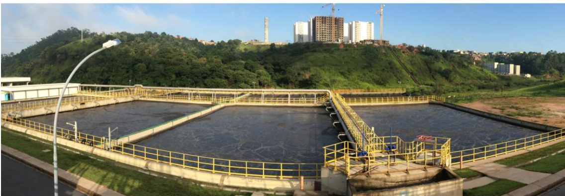
Figura 2 - Vista dos reatores RFA, com caixa divisora de vazão à frente.
