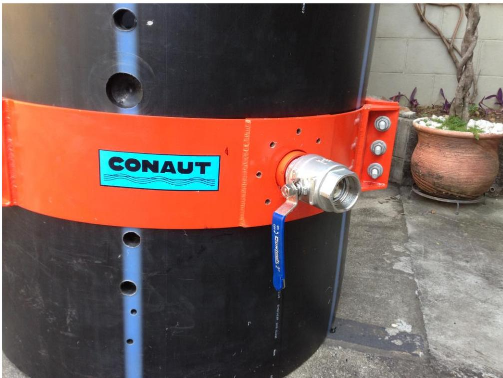
**Foto 1 – Válvula esférica de 2” acoplada em cinta tripartida instada em tubulação de PE 100 DN 1000mm**
