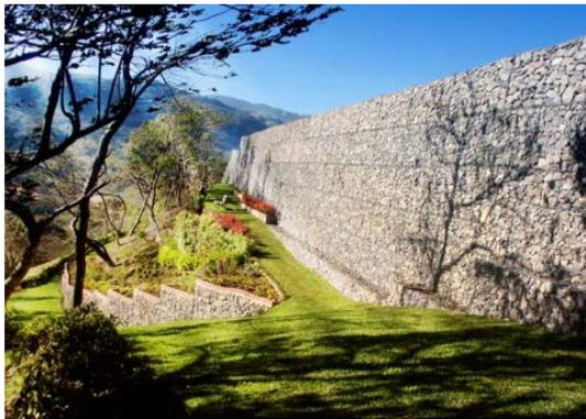
**Figura 1. Contenção em Gabiões**
