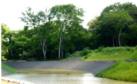
**Figura 2. Proteção de margem em colchões Reno**
