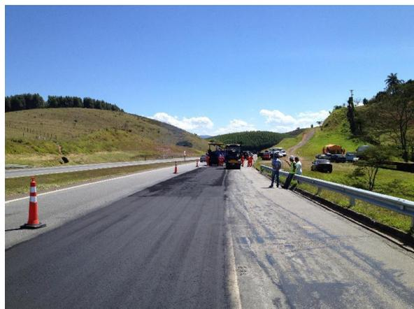
**Fotografia 8: Execução da Base da Pavimentação. Fotografia 9: Pavimentação acabada.**
