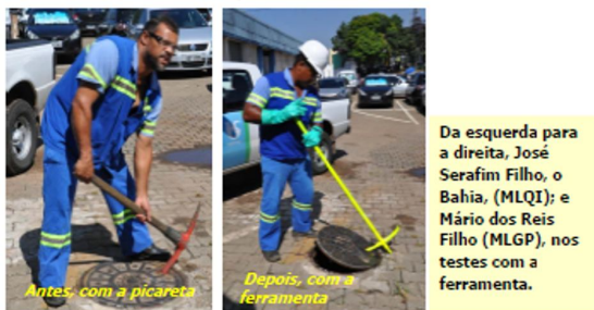
Foto 4: Ferramenta ergométrica para abertura de tampões
