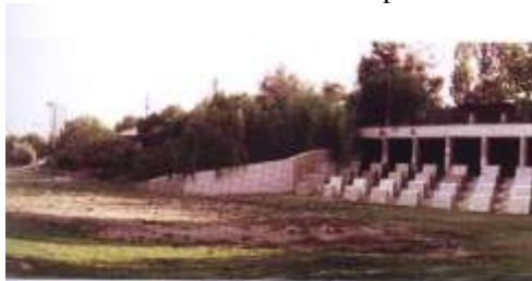
Figura 14: Estrutura de entrada na bacia de retenção/detenção, associada à área de lazer. Fonte: CANHOLI (2005).
