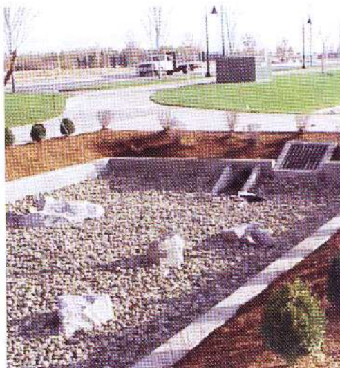
Figura 11: Bacia de percolação. Fonte: CANHOLI (2005)
