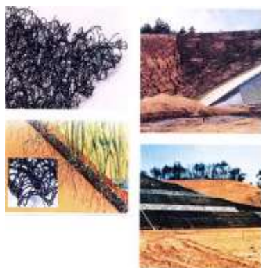
Figura 12 – Proteção direta – Geomanta tipo “flatback” Fonte: SILVA, (2004).
