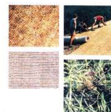
Figura 13 – Proteção direta – Biomanta. Fonte: SILVA (2004).
