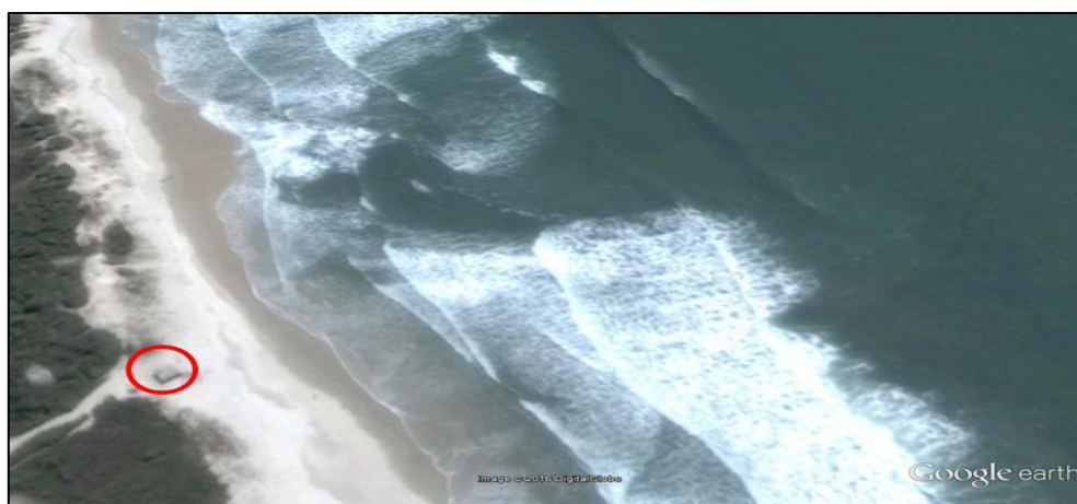
Figura 3: Instalação de captação horizontal de água salina localizada na Barra da Lagoa, Florianópolis, SC.
