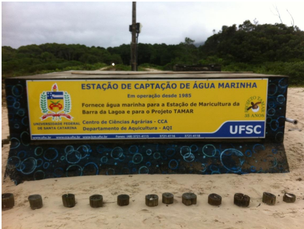
Figura 4: Estação de captação de água marinha (sistema de captação horizontal).
