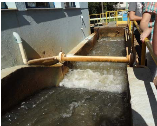
Figura 1: Processo de coagulação, com o uso de vertedor e adição do coagulante PAC (policloreto de alumínio).
