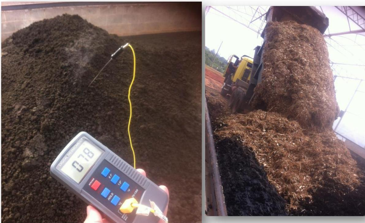
Figura 5 – Mistura do lodo com o material estruturante e medição da temperatura nas leiras.
