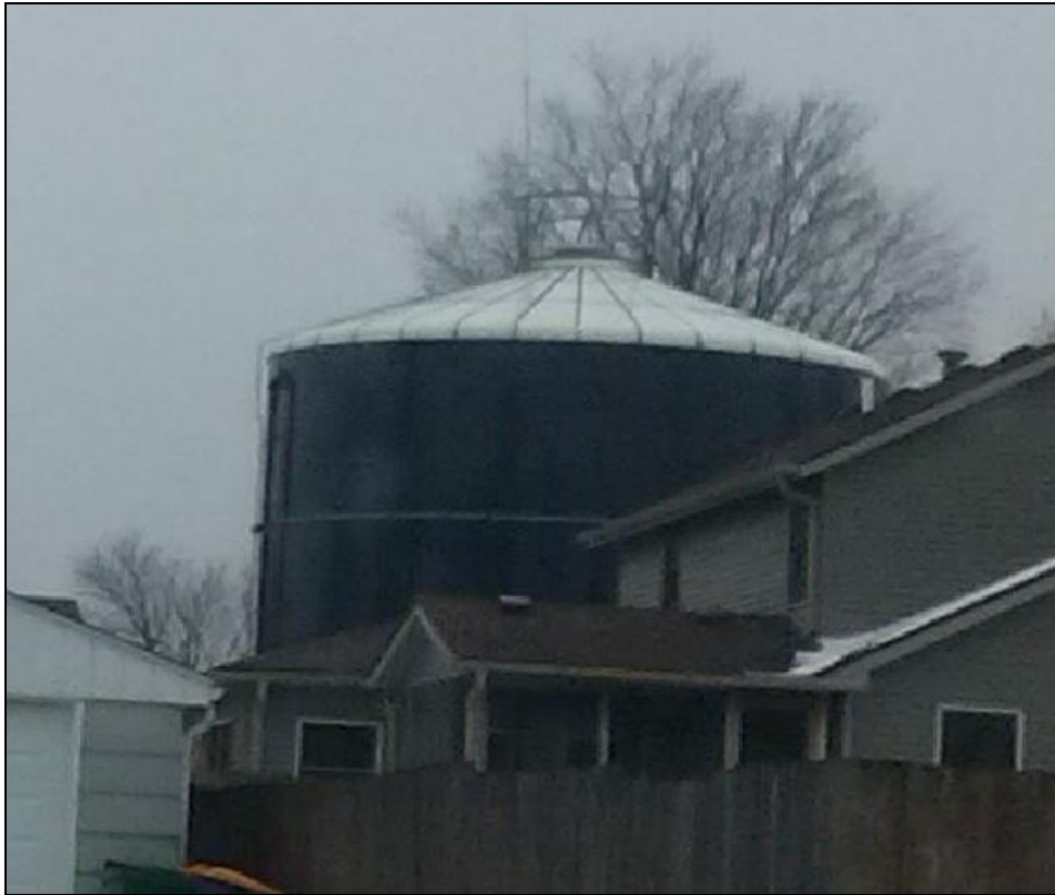
Figura 16- Detalhe do Domus em aço vitrificado
