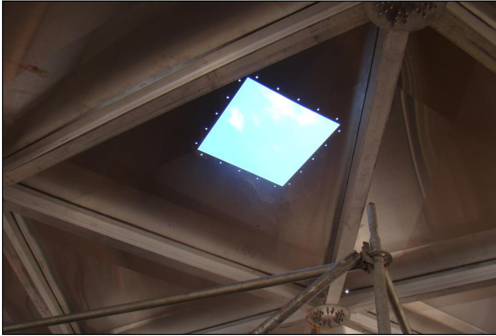
Figura 9 - Detalhe da abertura para janela de ventilação
