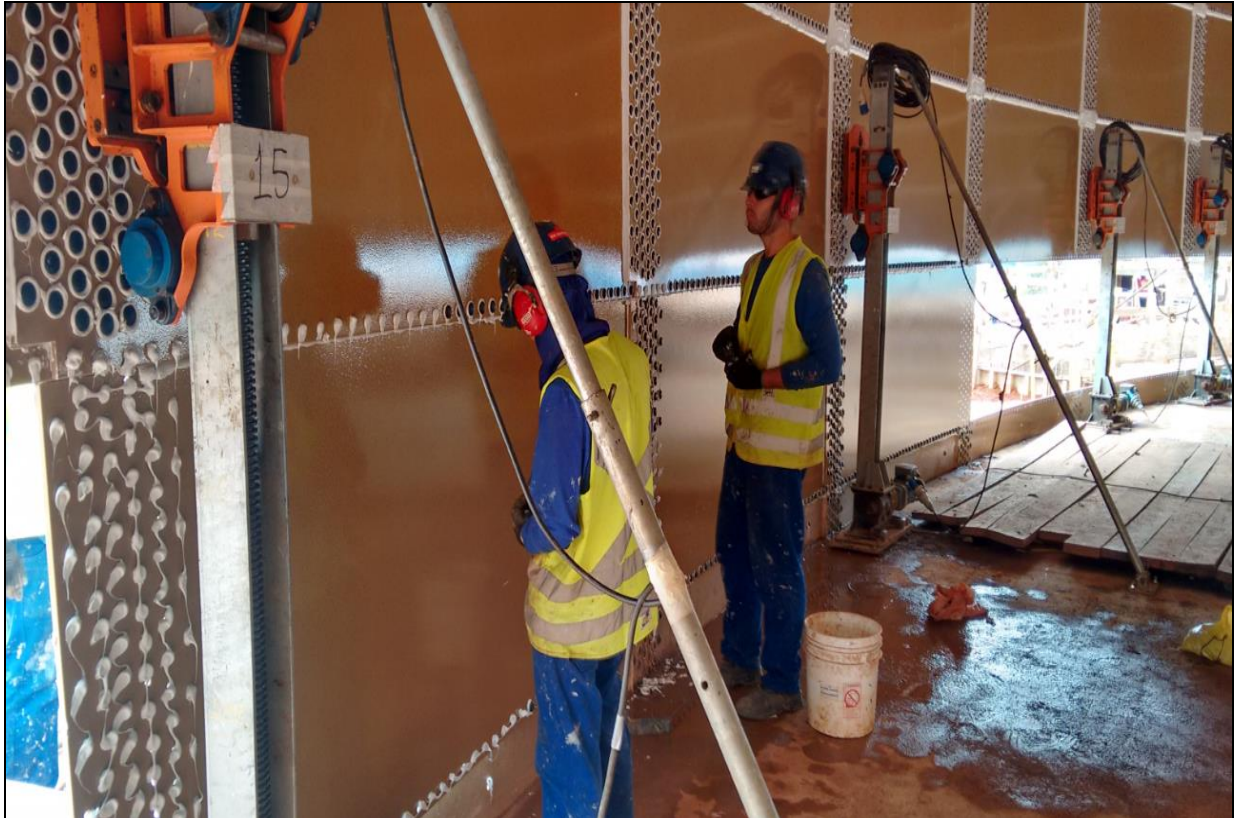
Figura 24 - Vista dos macacos elétricos de elevação no processo de montagem das placas de aço.
