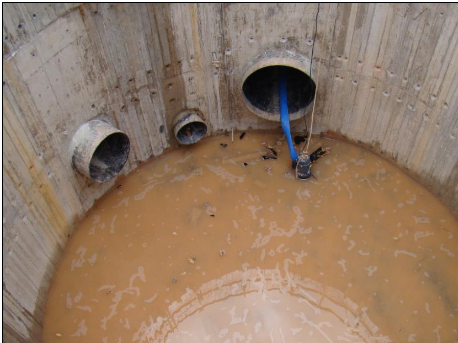
Figura 12 - Poço executado no "Reservatório Anchieta" com saída abaixo da soleira do reservatório.
