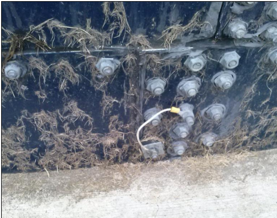
Figura 17 - Detalhe externo do anodo de sacrificio da proteção catódica
