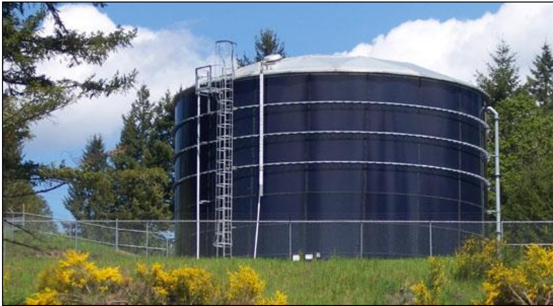
Figura 1 - Típico tanque de aço vitrificado com domus em alumínio e acessórios de montagem.
