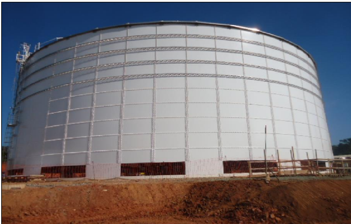
Figura 23 - Vista externa de um dos três RCAB - Reservatórios de Compensação de Água Bruta de 25.000m 3 da ETA Vargem Grande - SPSL.
