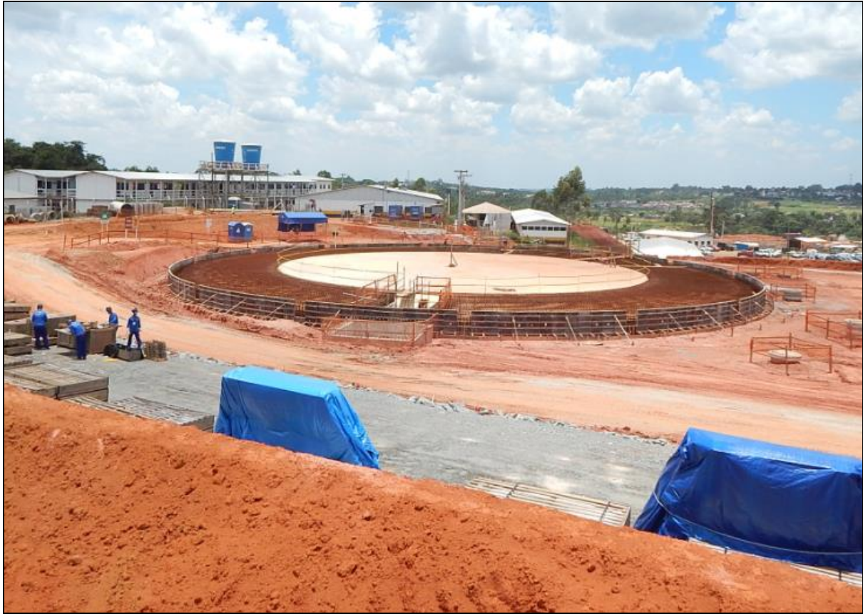
Figura 19 - Montagem da base do Reservatório Metálico Parafusado ETA V.G. do SPSL.
