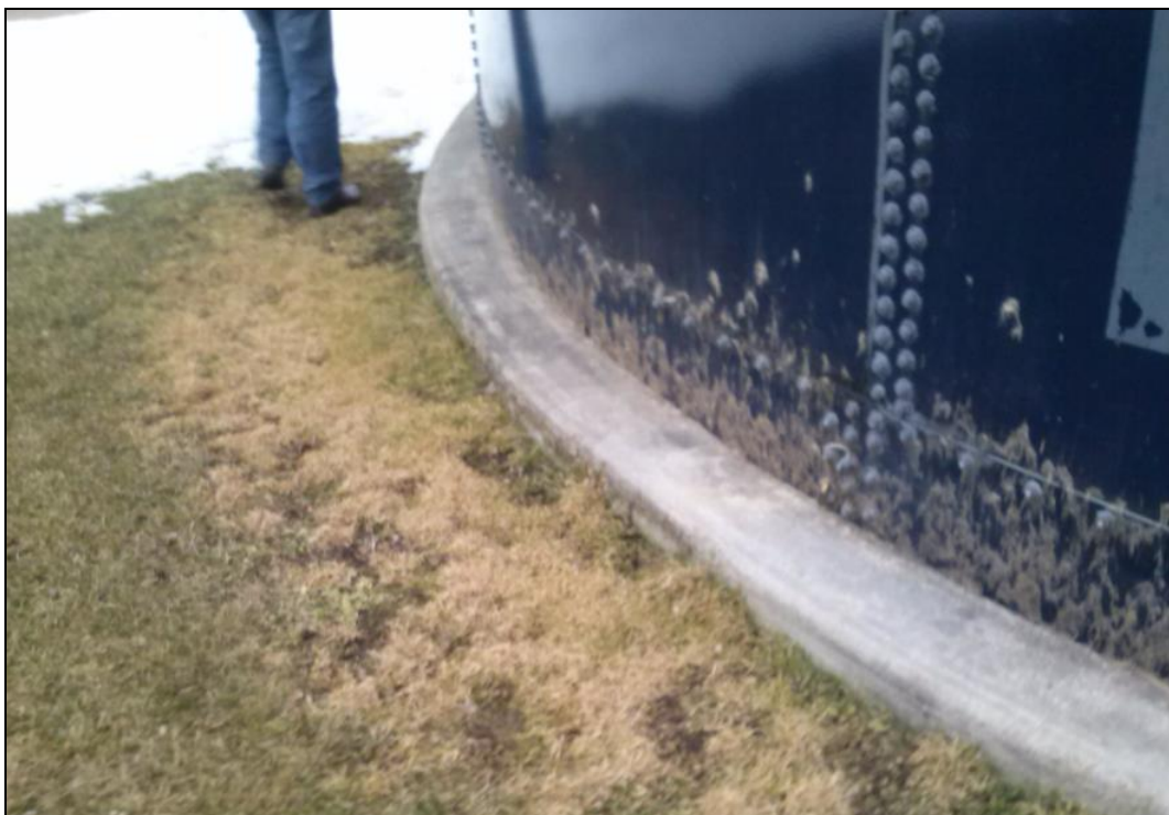
Figura 15 - Detalhe da perfeita estanqueidade
