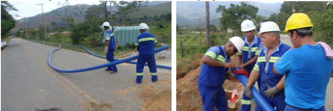
Foto 10 a 13: Preparação, alinhamento, assentamento e soldagem por eletrofusão do tubo PEAD
